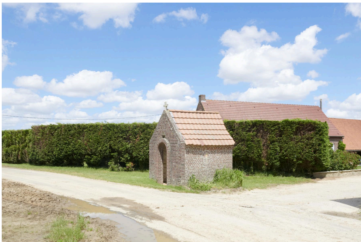
Vue générale de la chapelle.
