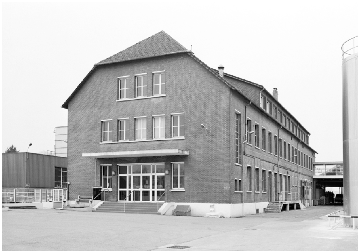
Vue générale nord-est du bâtiment social.
