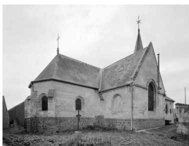
Élévation nord. Phot. Jean-Michel Périn IVR22_19846001292V
