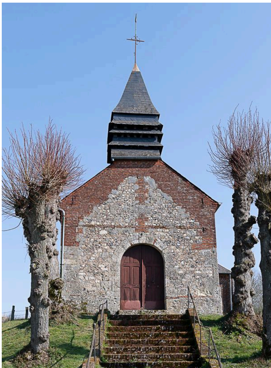
Vue de la façade occidentale.
