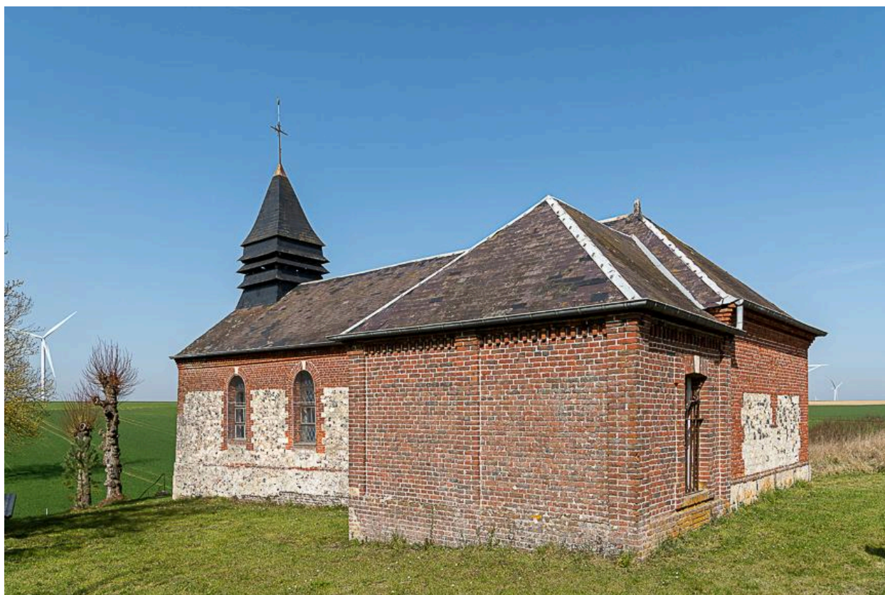
Vue depuis le sud-est.
