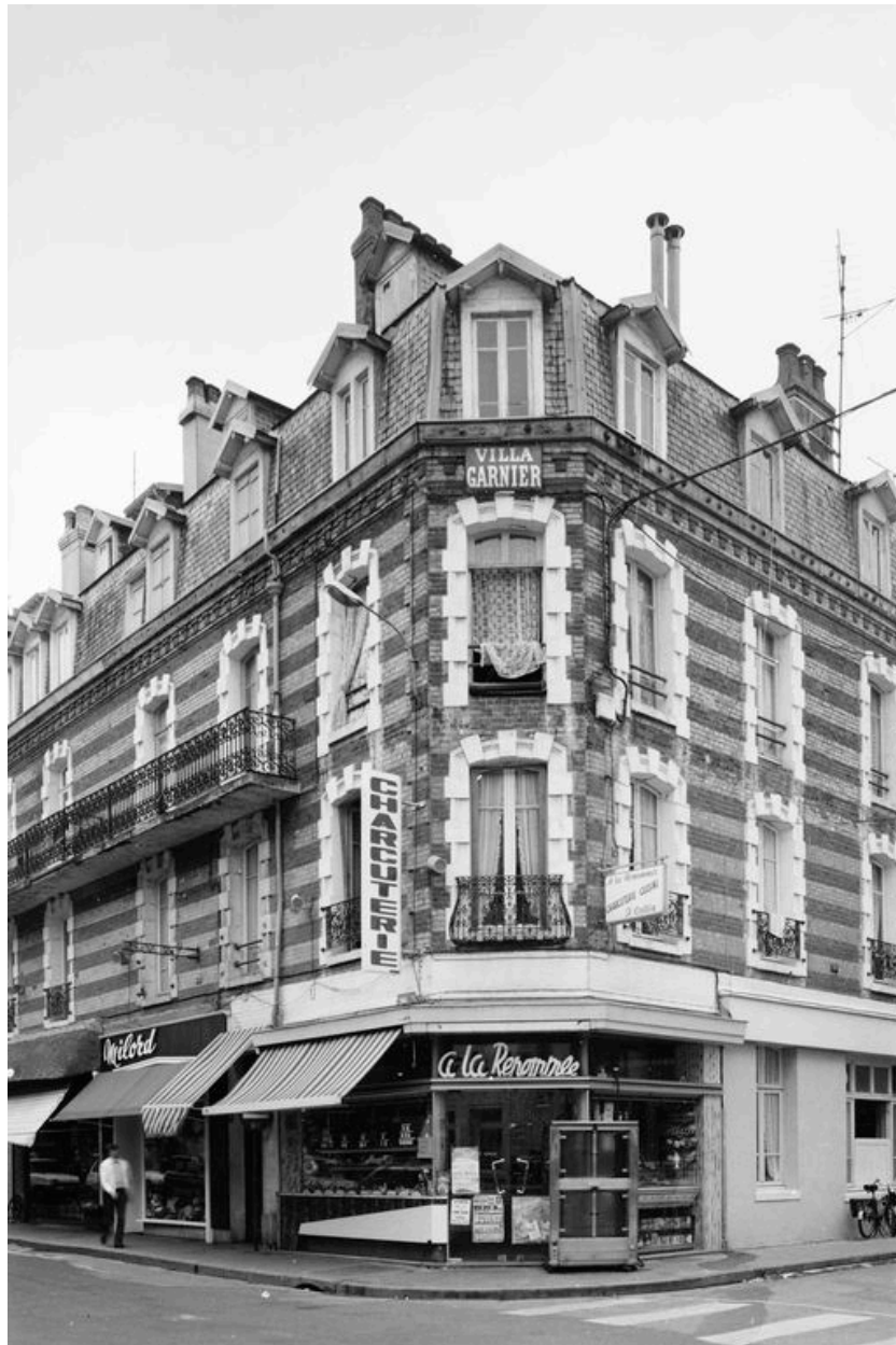
Vue générale de la Villa Garnier, immeuble 35 rue Carnot en 1981.
