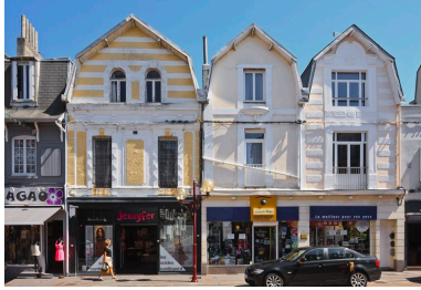
Alignement de chalets dans la rue Carnot. Phot. Hubert Bouvet IVR31_20136200185NUCA
