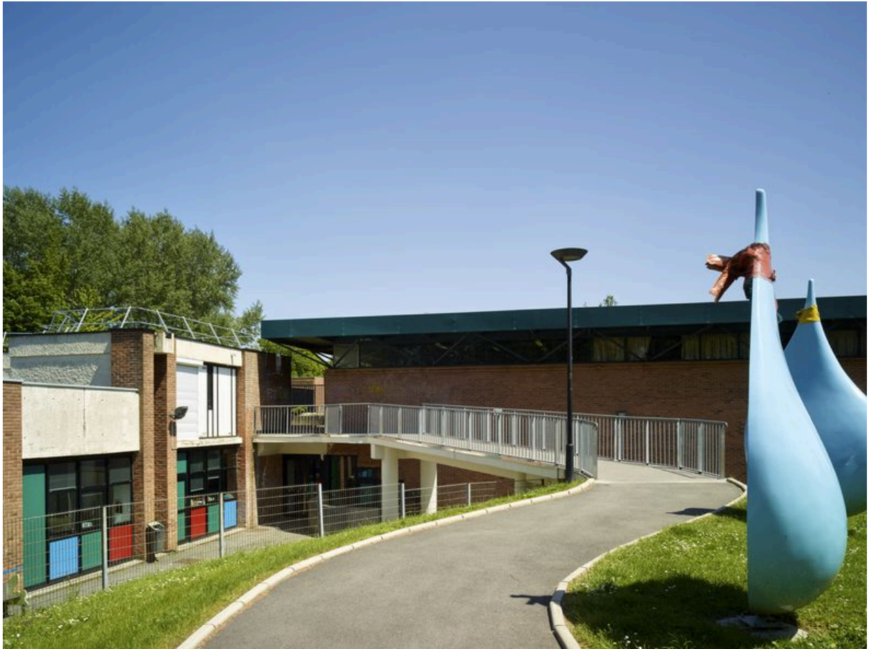
Passerelle conduisant à la salle Charles-le-Bon, à l'étage.
