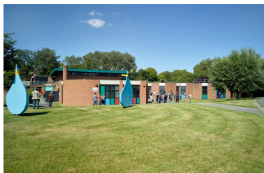
Vue générale depuis le sud. Phot. Pierre Thibaut IVR32_20185900741NUCA
