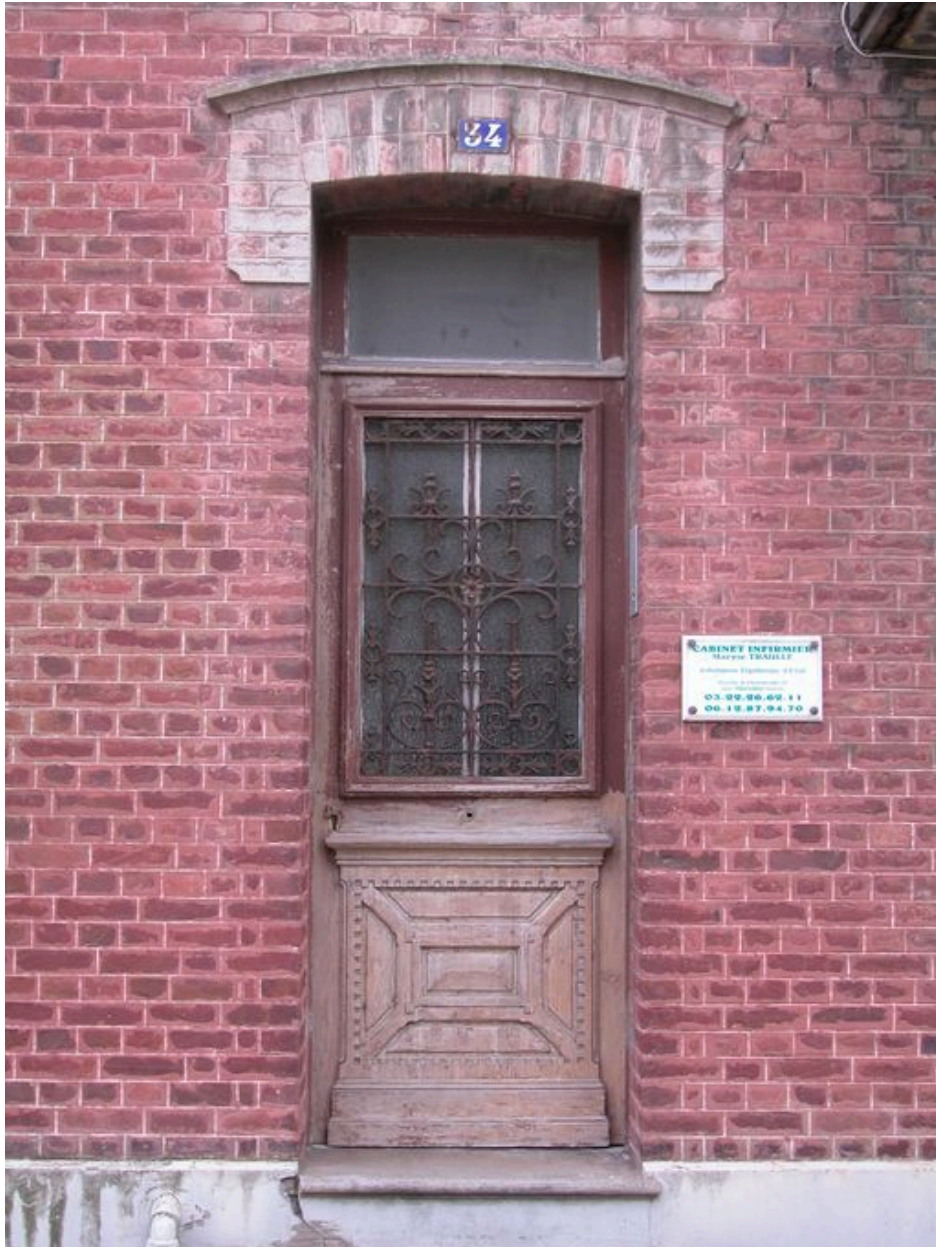
Détail d'une porte d'entrée.
