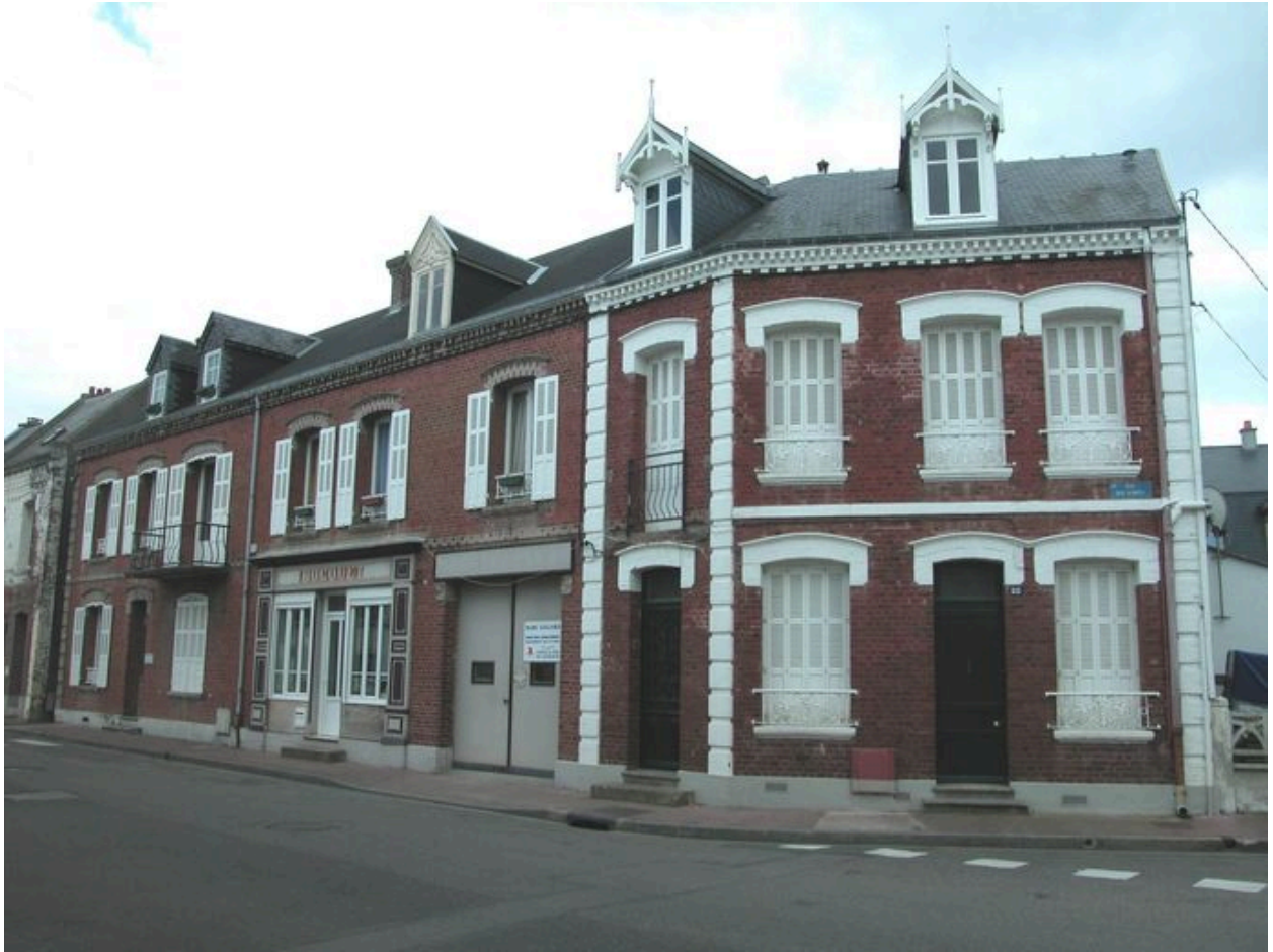
Vue d'ensemble des trois logements accolés.
