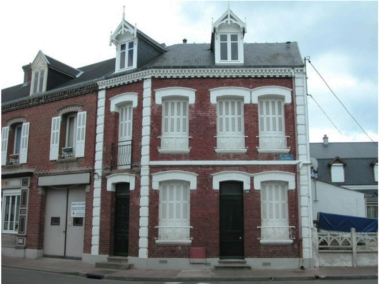
Vue d'ensemble du logement de droite.
