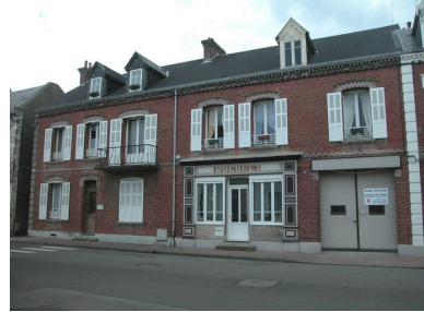
Vue d'ensemble des deux logements de gauche. Phot. Elisabeth Justome IVR22_20058003081NUCA
