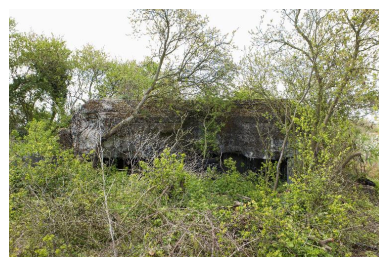
Vue vers l'ouest Phot. Jean-Marc Ramette IVR31_20145904295NUCA
