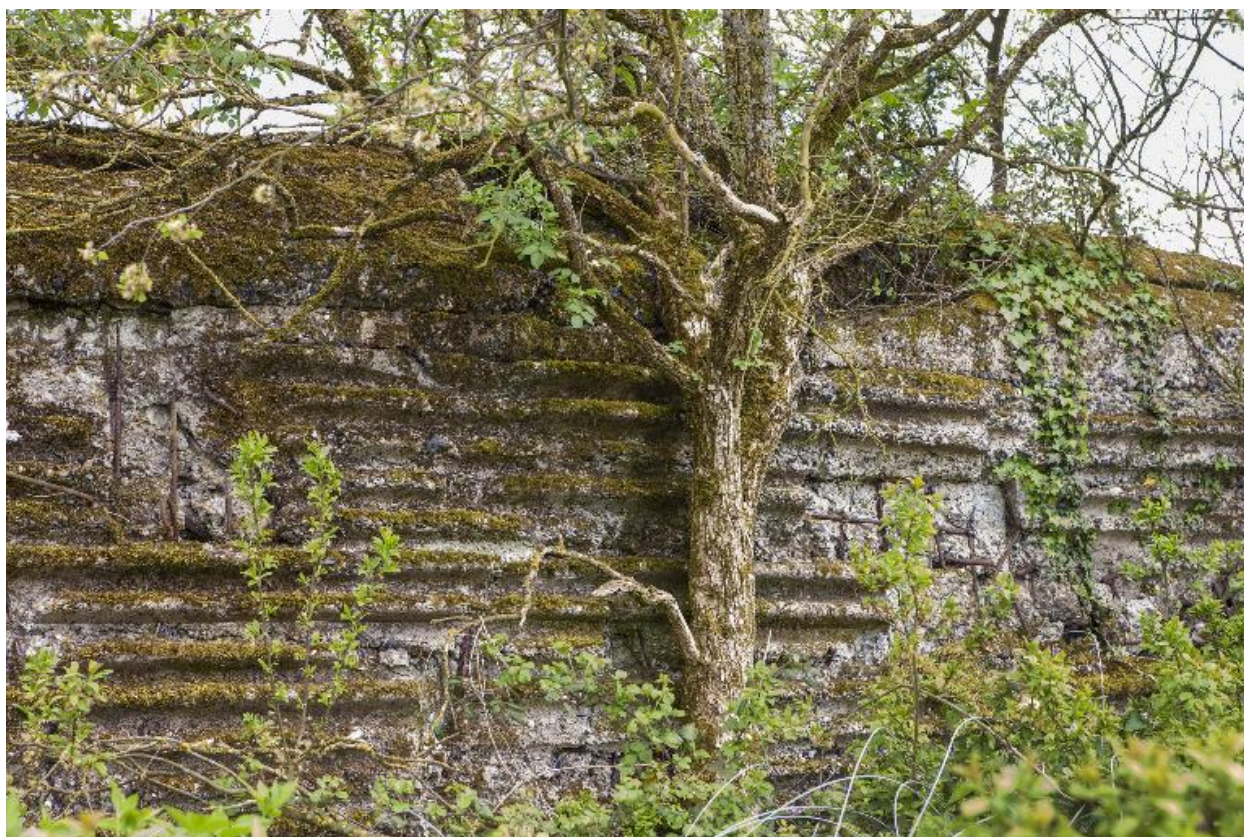
Elévation Ouest, trace de coffrage.
