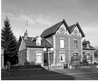
Vue générale. Phot. Thierry Lefébure IVR22_19960201047X
