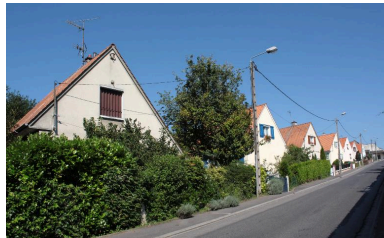
Vue d'ensemble des maisons de cadres Saint Frères construites entre 1954 et 1958. Phot. Bertrand Fournier IVR22_20138016139NUC2A
