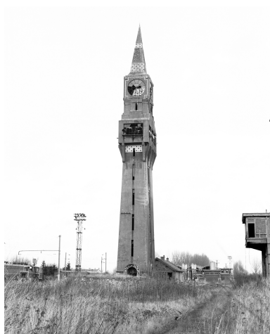
Vue générale de la tour en 1980. Phot. Philippe Caudroit IVR31_19805900227X
