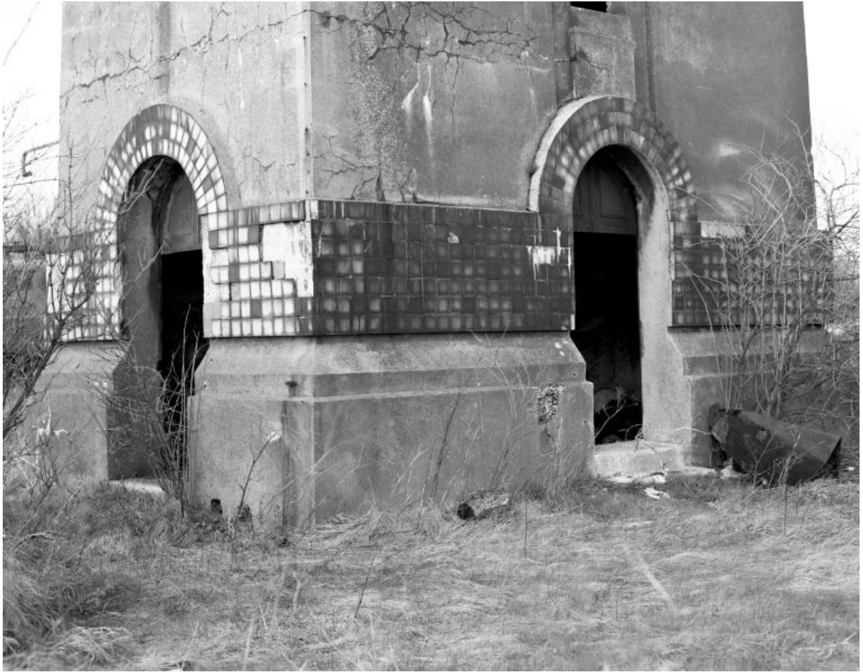
La base de la tour d'aiguillage.
