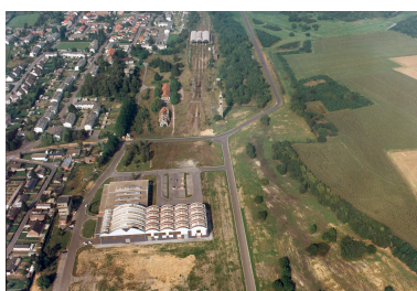
Vue aérienne du quartier Le Petit Maubeuge ; la tour Florentine et les nouveaux hangars (photographie aérienne NAI Felleries). Phot. Photographe inconnu IVR31_20025900196NUC
