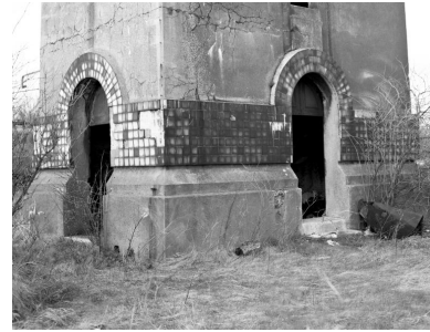
La base de la tour d'aiguillage. Phot. Philippe Caudroit IVR31_19805900224X
