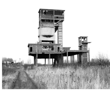
Toboggan à charbon, vue latérale (détruit). Phot. Philippe Caudroit IVR31_19805900225X
