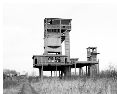
Toboggan à charbon, vue latérale (détruit). Phot. Philippe Caudroit IVR31_19805900228X
