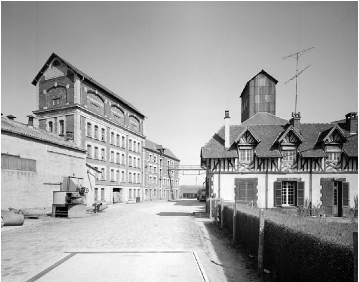
Atelier de fabrication, magasins et logement, depuis la cour.
