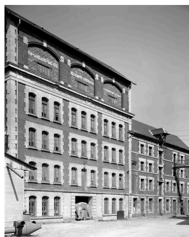
Bâtiments situés au bord de la Verse. Phot. Jean-Michel Périn IVR22_19856000583V
