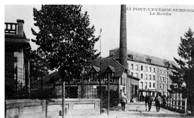
Vue générale, avant 1914 (AP). Phot. Jean-Michel Périn (reproduction) IVR22_19856000261XB
