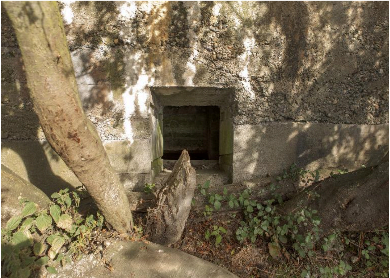
Ouverture dans l'élévation sud
