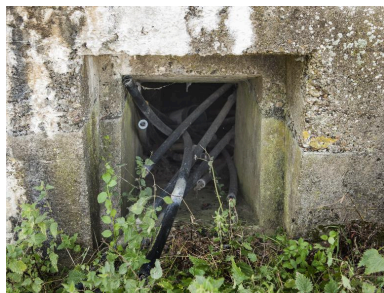
Ouverture dans l'élévation nord Phot. Jean-Marc Ramette IVR31_20145904615NUCA
