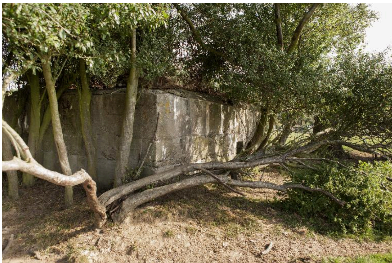
Elévation sud, vers le nord-est
