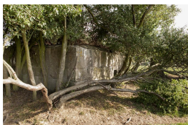
Elévation sud, vers le nord-est Phot. Jean-Marc Ramette IVR31_20145904617NUCA
