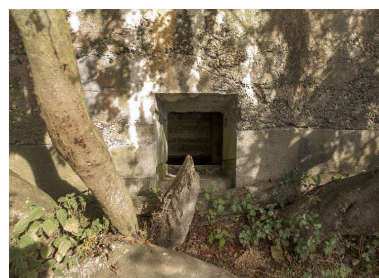
Ouverture dans l'élévation sud Phot. Jean-Marc Ramette IVR31_20145904619NUCA
