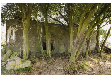
Elévation ouest Phot. Jean-Marc Ramette IVR31_20145904616NUCA
