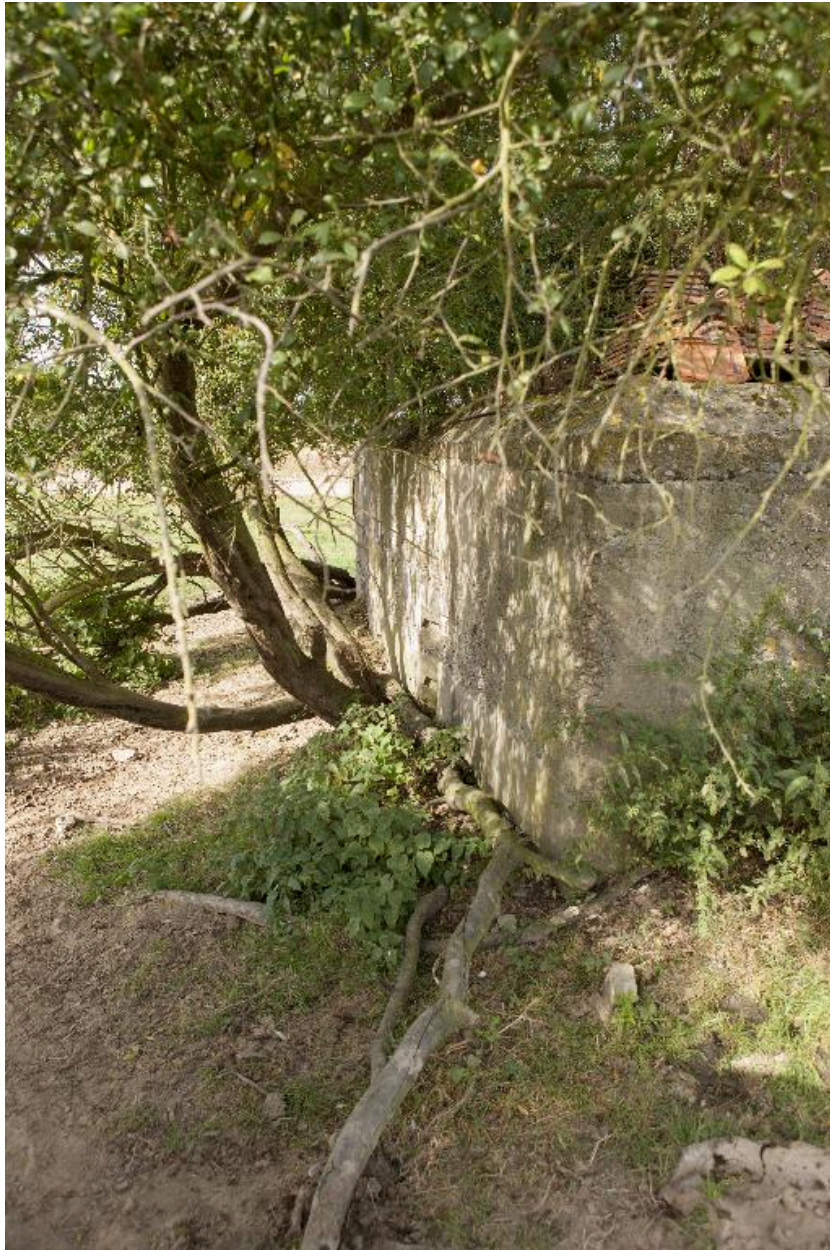
Elévation sud, vers le nord-ouest
