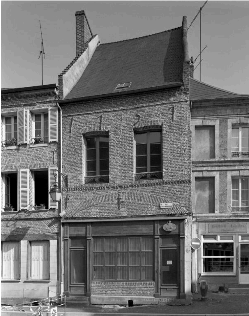
Vue de la façade sur rue.
