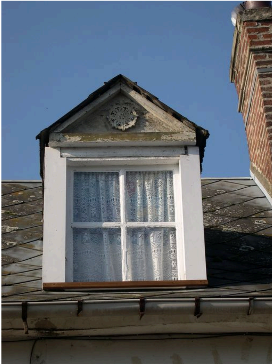
Détail sur une des lucarnes.
