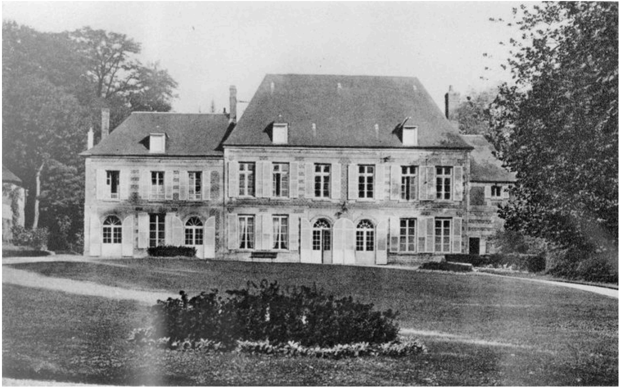
Logis. Elévation antérieure (AP).
