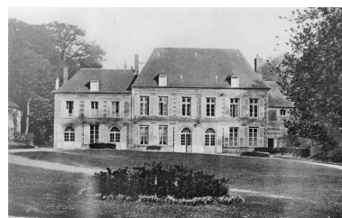
Logis. Elévation antérieure (AP). Phot. Jean-Michel Périn IVR22_19856000338XB
