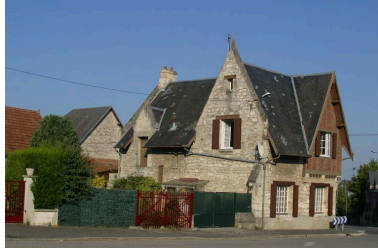
Vue latérale. Phot. Inès Guérin IVR22_20050200890NUCA
