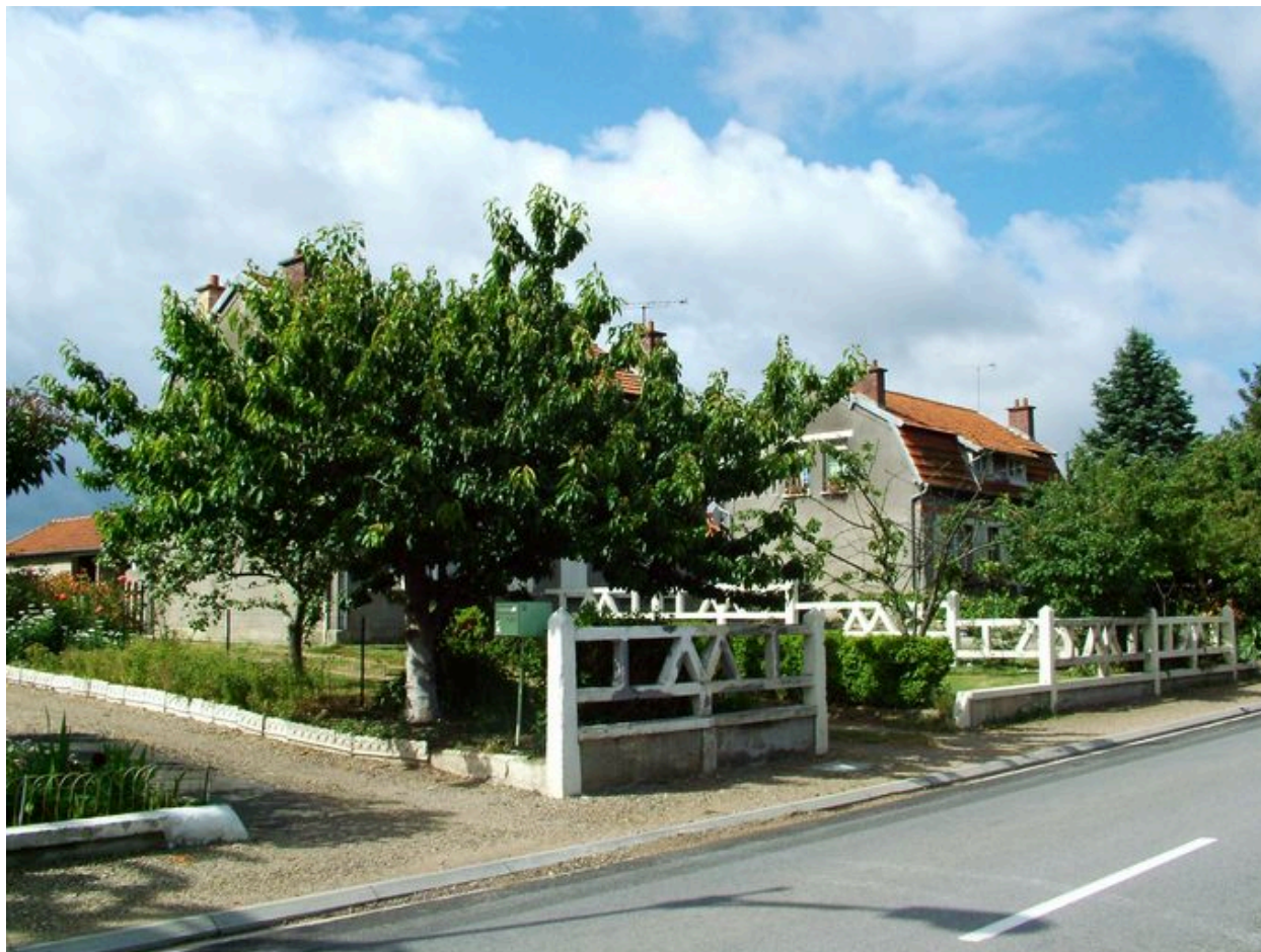
Vue d'une enfilade de maisons ouvrières.
