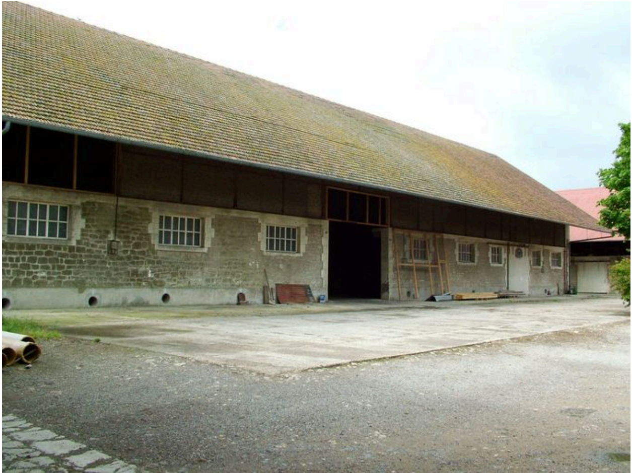
Vue d'un bâtiment agricole.
