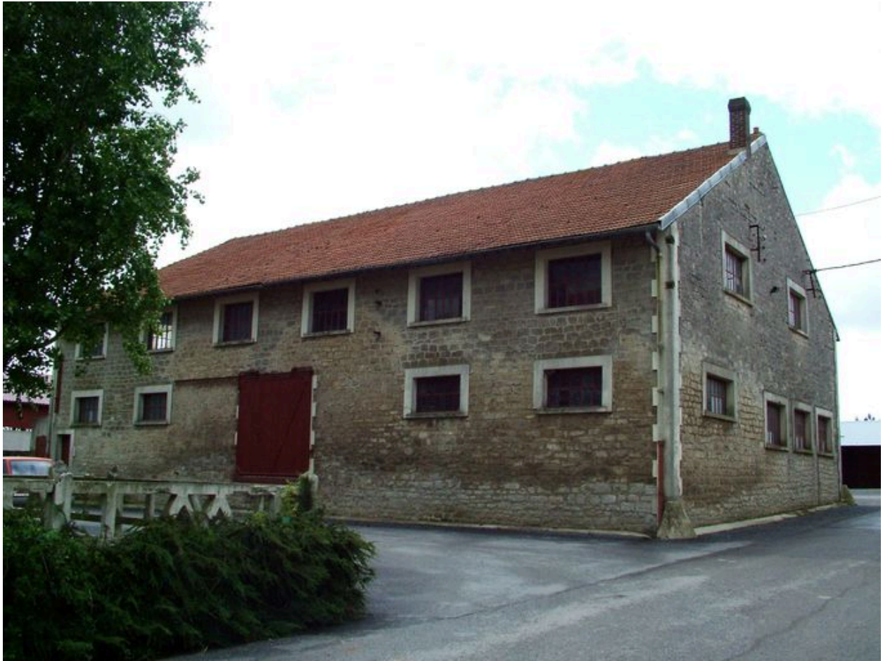
Vue d'un bâtiment agricole.
