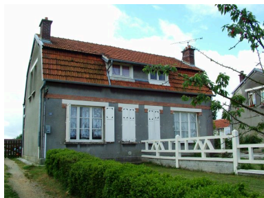
Vue d'une maison ouvrière. Phot. Inès Guérin IVR22_20030202196NUCA
