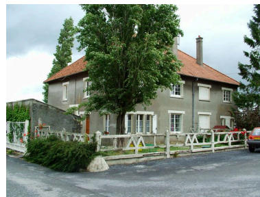
Vue d'une maison ouvrière collective. Phot. Inès Guérin IVR22_20030202192NUCA
