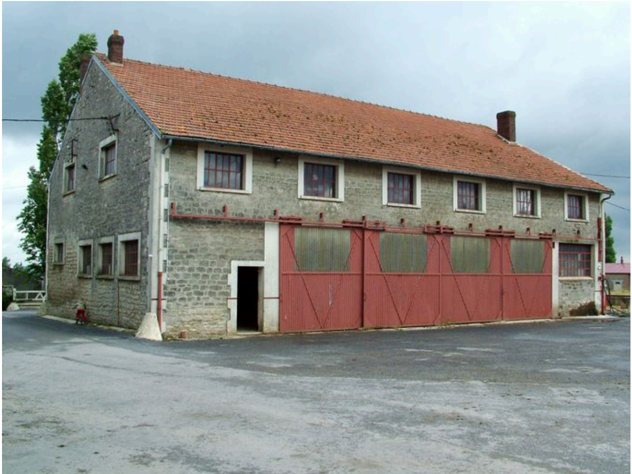
Vue d'un bâtiment agricole.
