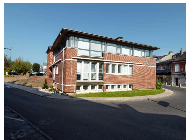
Vue des extensions de la mairie d'Escarbotin. Phot. Thierry Lefébure IVR22_20148000484NUC2A
