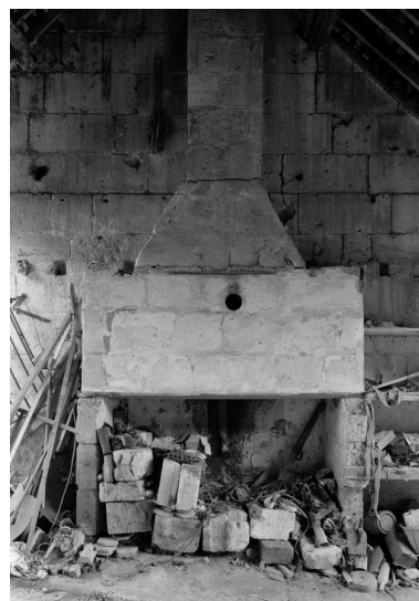
Cheminée du logis. Phot. Jean-Michel Perrin IVR22_19856000564X
