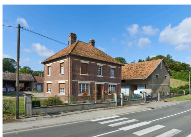
Ferme Fourdrinier, 10 route d'Abbeville, vue prise depuis le nord. Phot. Thierry Lefébure
