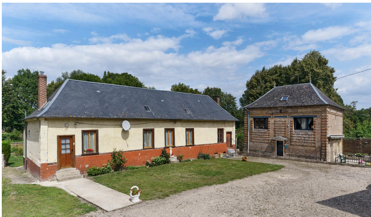
Ancienne école de Vieulaines, 27 rue du Bas, vue prise depuis le sud-ouest.
