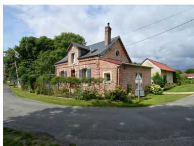
Ancienne ferme Chevallier, 20 rue d'en Bas, vue prise depuis le nord-est.
