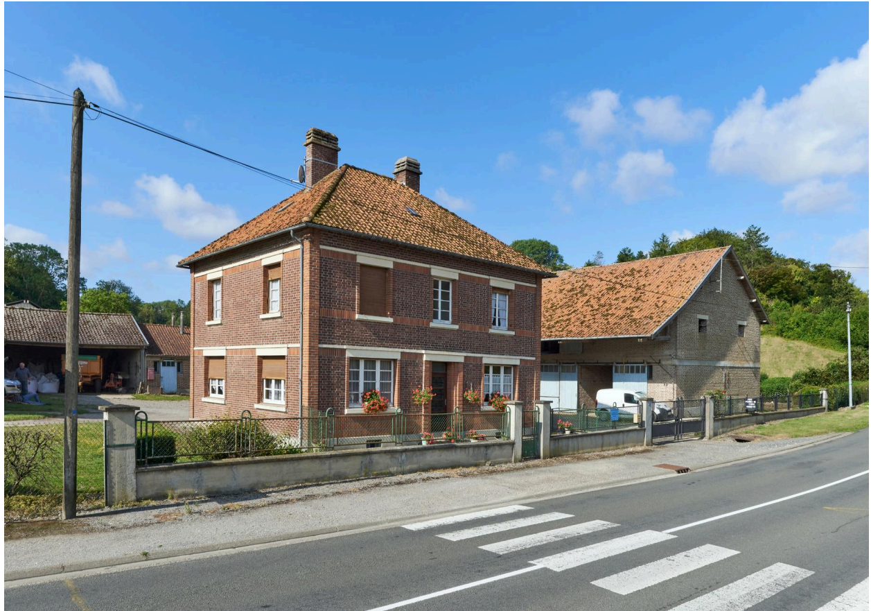
Ferme Fourdrinier, 10 route d'Abbeville, vue prise depuis le nord.
