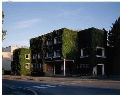
Vue générale. Phot. Thierry Petitberghien IVR31_19945901063VA
