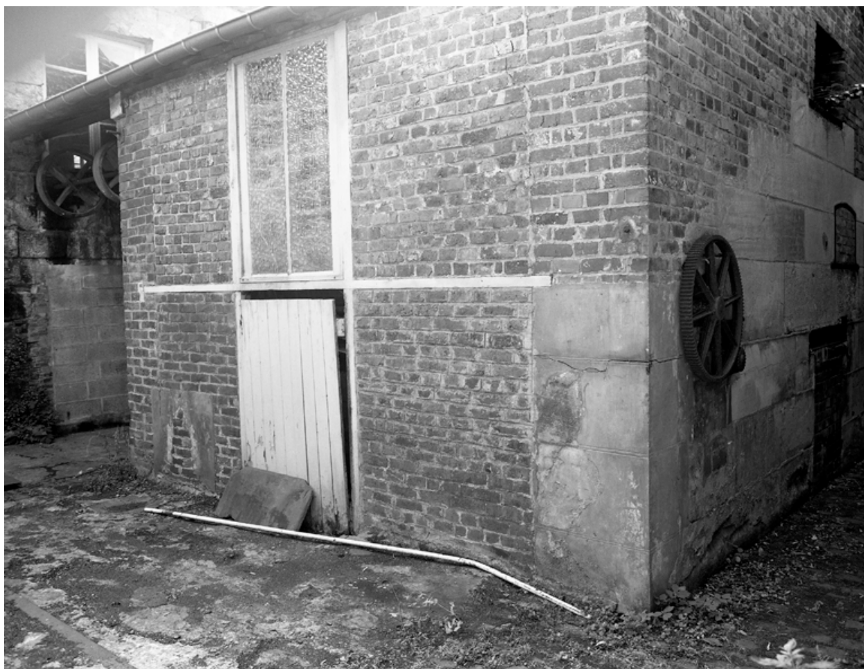
Façade nord de la salle des machines.
