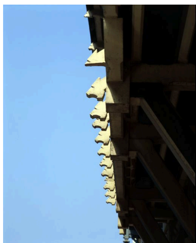
Effet décoratif d'un garde-corps (1er étage-carré).
