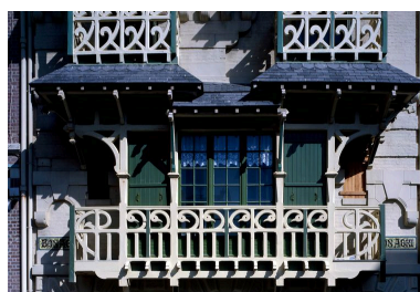
Détail des balcons. Phot. Irwin Leullier IVR22_20008000661XA
