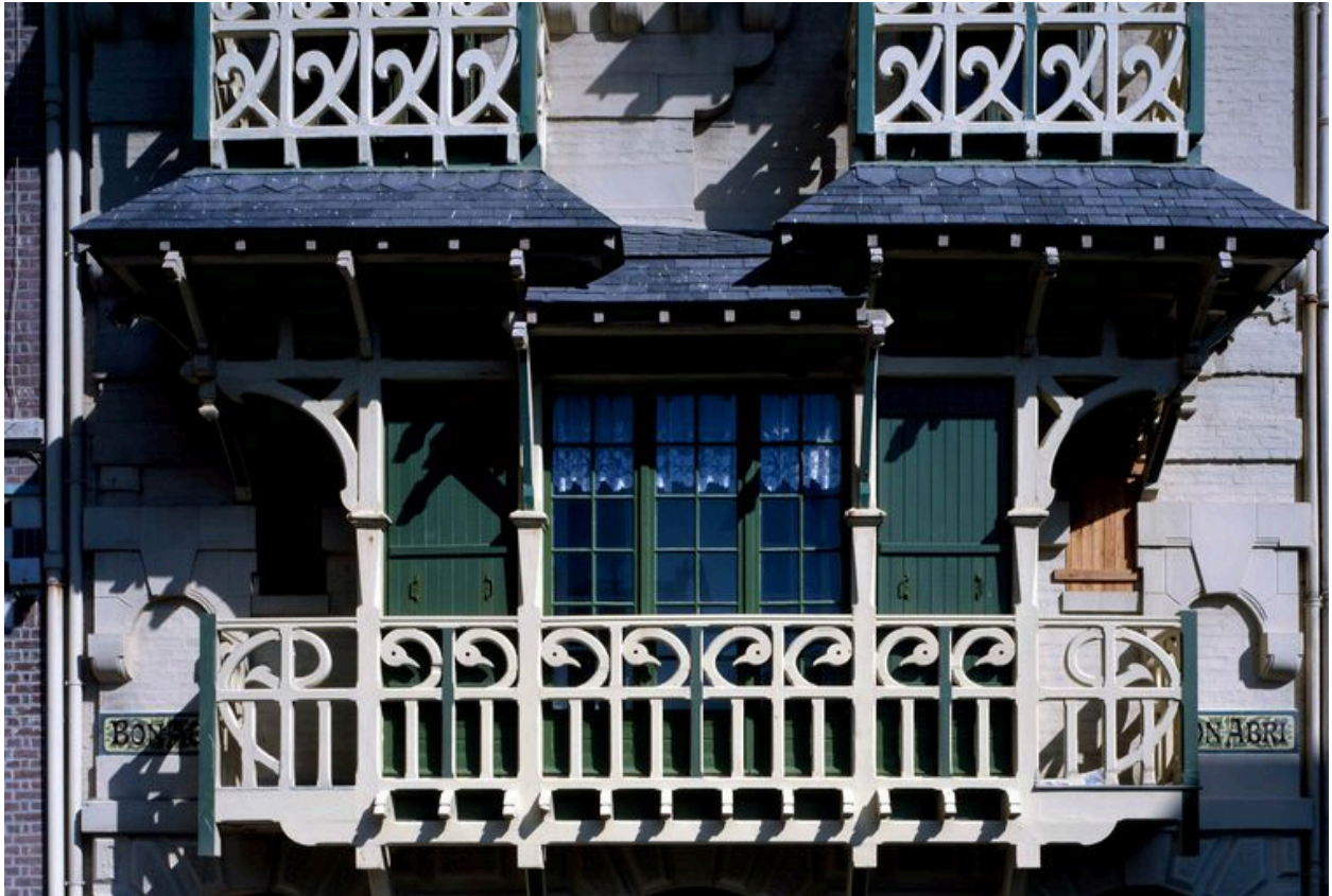
Détail des balcons.
