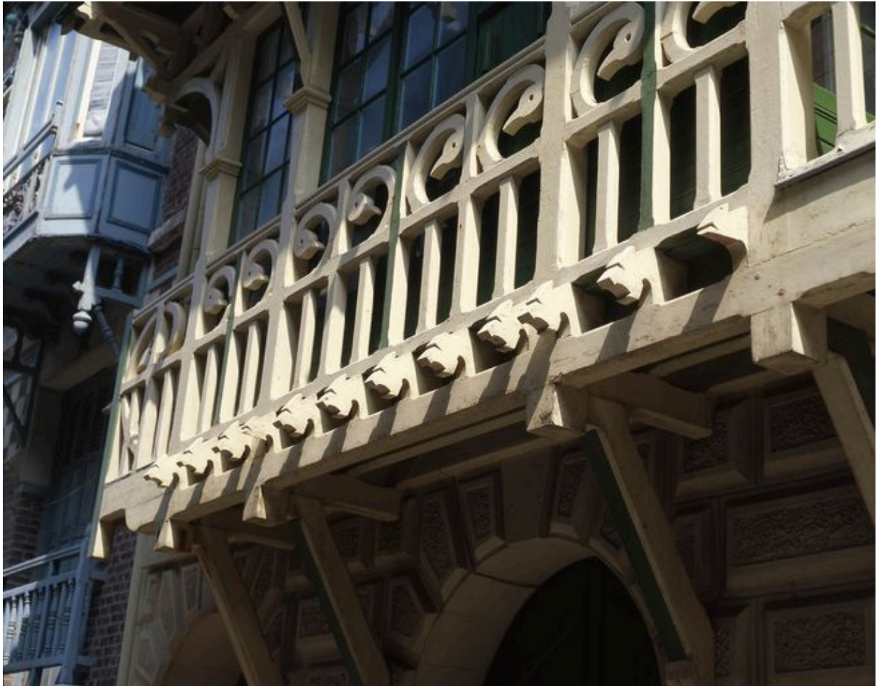
Détail d'un garde-corps en menuiserie (1er étage-carré).
