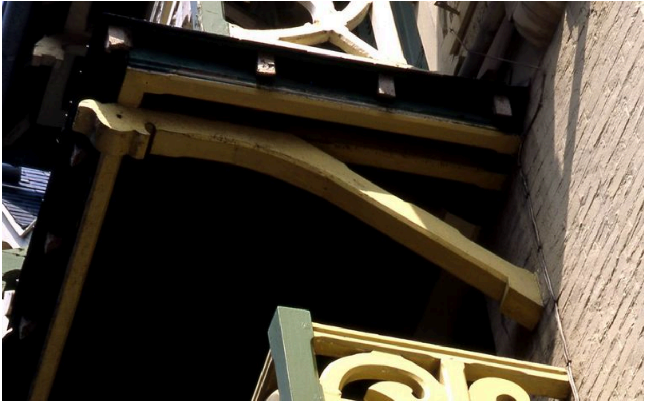
Détail d'un aisselier supportant la plate-forme du balcon du 2e étage-carré.
