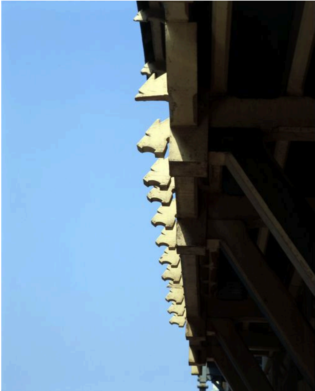
Effet décoratif d'un garde-corps (1er étage-carré).
