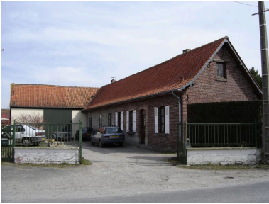
Vue générale. Phot. Inès Guérin IVR22_20058005063NUCA
