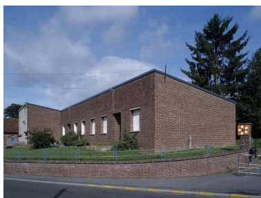
Vue de trois-quarts du bâtiment de la mairie et des logements.
