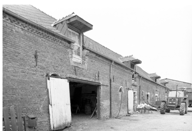
Vue d'ensemble de l'élévation sur cour de l'étable sud-est. Phot. Thierry Lefébure IVR22_19920201322Z
