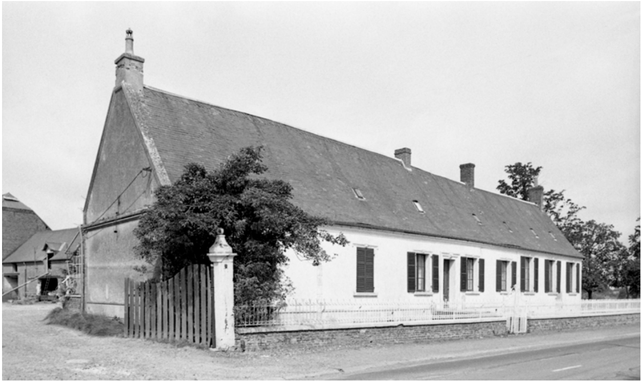
Vue d'ensemble du logis depuis le sud-est.
