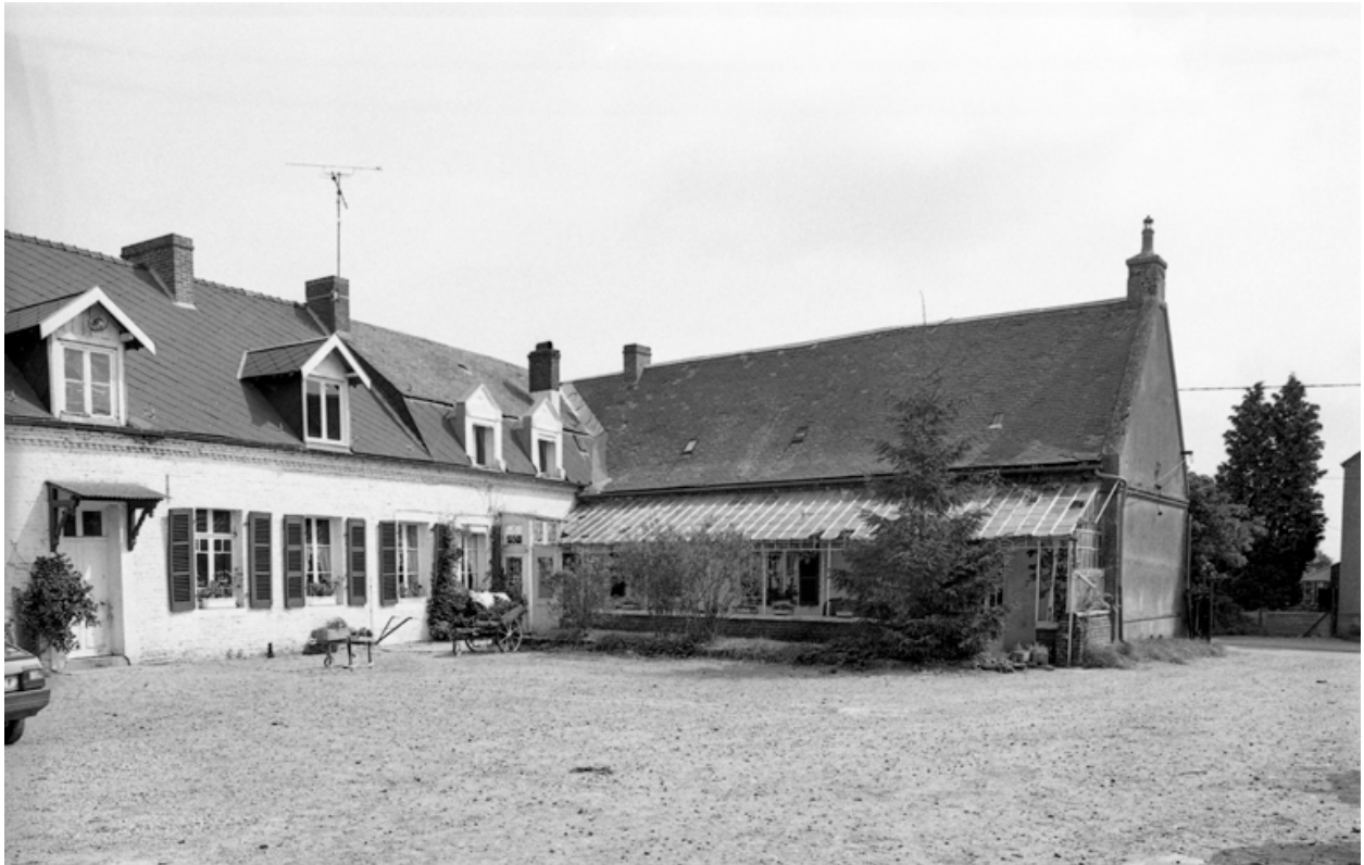
Vue d'ensemble de l'élévation sur cour du logis.
