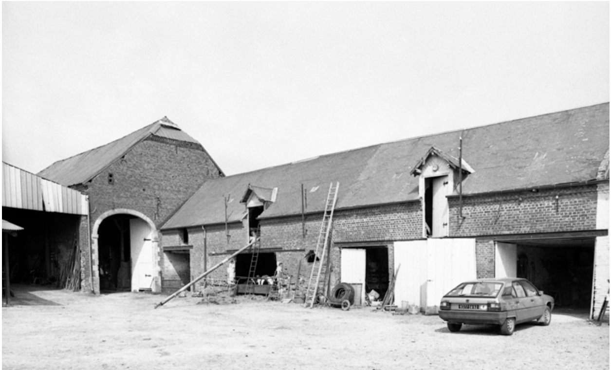
Elévations sur cour de l'étable et de la grange nord-ouest.
