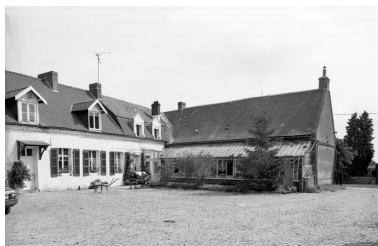
Vue d'ensemble de l'élévation sur cour du logis. Phot. Thierry Lefébure IVR22_19920201317Z
