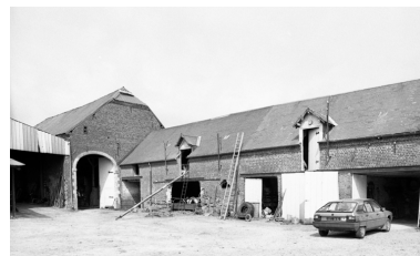
Elévations sur cour de l'étable et de la grange nord-ouest. Phot. Thierry Lefébure IVR22_19920201318Z
