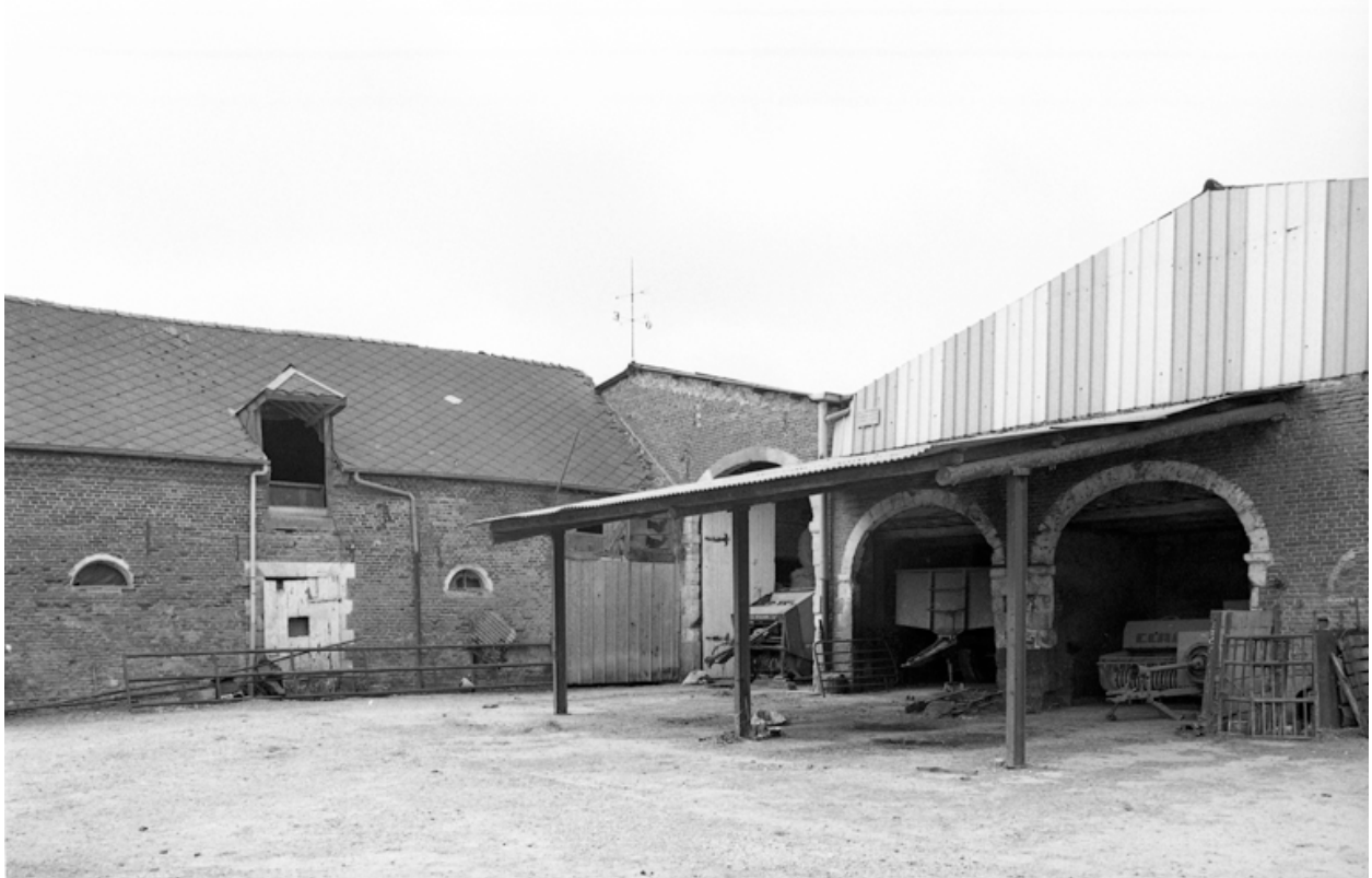
Elévations sur cour des étables et de la grange sud.
