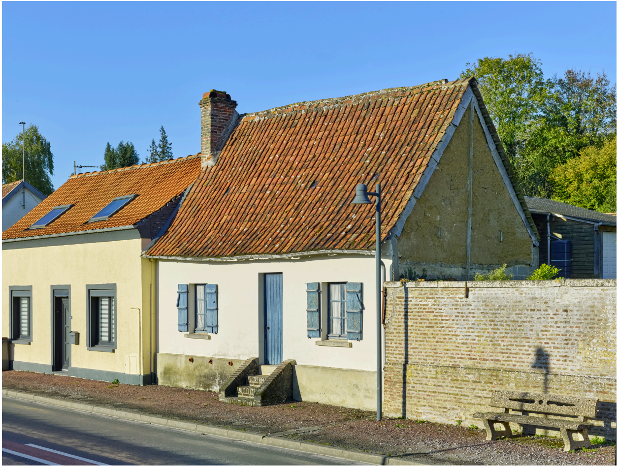
Vue de trois quarts de la maison, depuis la rue.
