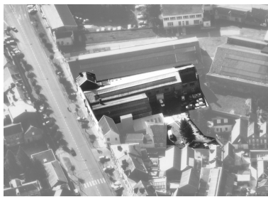
Vue aérienne du site en 1989. Phot. Pillet Frédéric, Autr. Phot'R IVR22_20060205536NUCA
