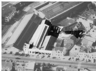
Vue aérienne du site en 1989. Phot. Pillet Frédéric, Autr. Phot'R IVR22_20060205535NUCA
