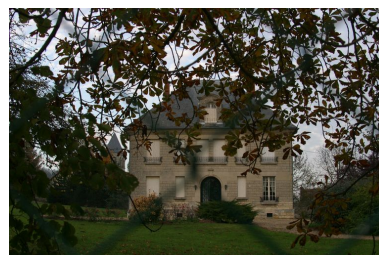
Vue générale. Phot. Inès Guérin IVR22_20030203128NUCA
