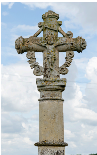
Partie supérieure. Phot. Marc Kérignard IVR32_20246000437NUCA
