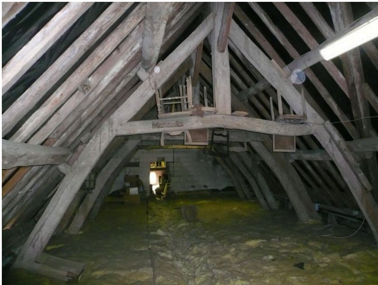
Vue de la charpente du logis.
