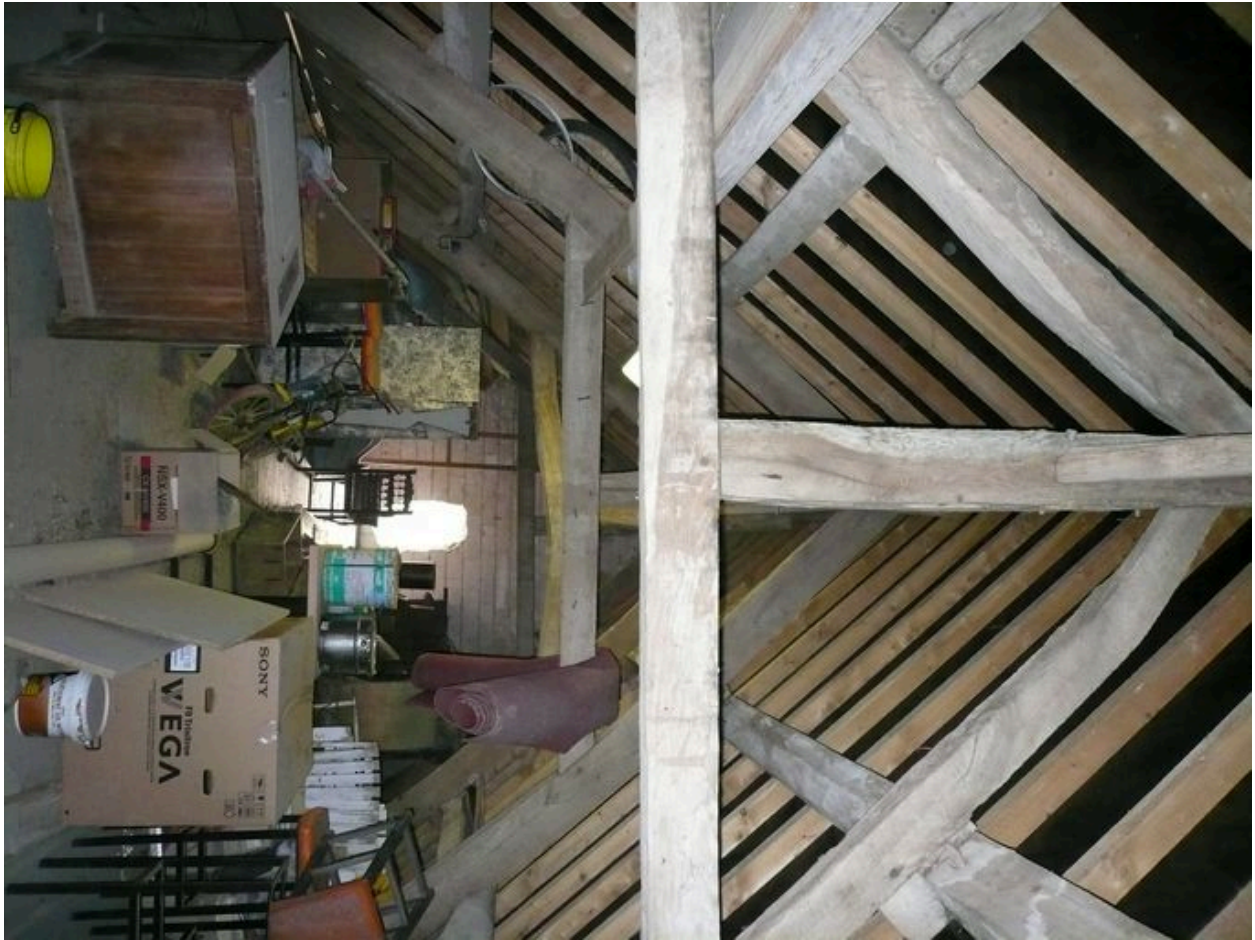
Vue de la charpente des écuries.
