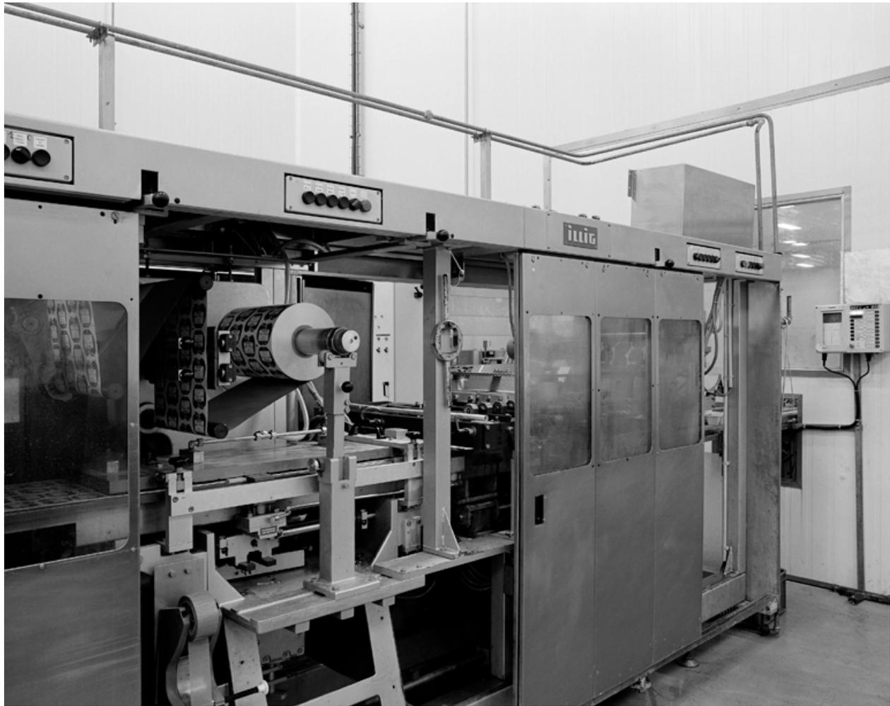
Partie de la ligne de thermoformage où les tetrapacks de compote de pommes reçoivent un opercule.
