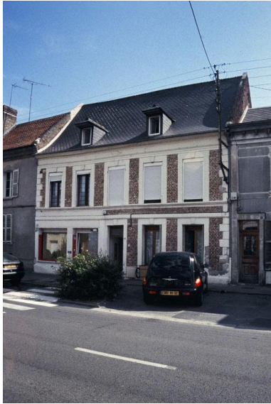
Vue de la façade sur rue. Phot. Frédéric Fournis IVR22_20030200166ZA
