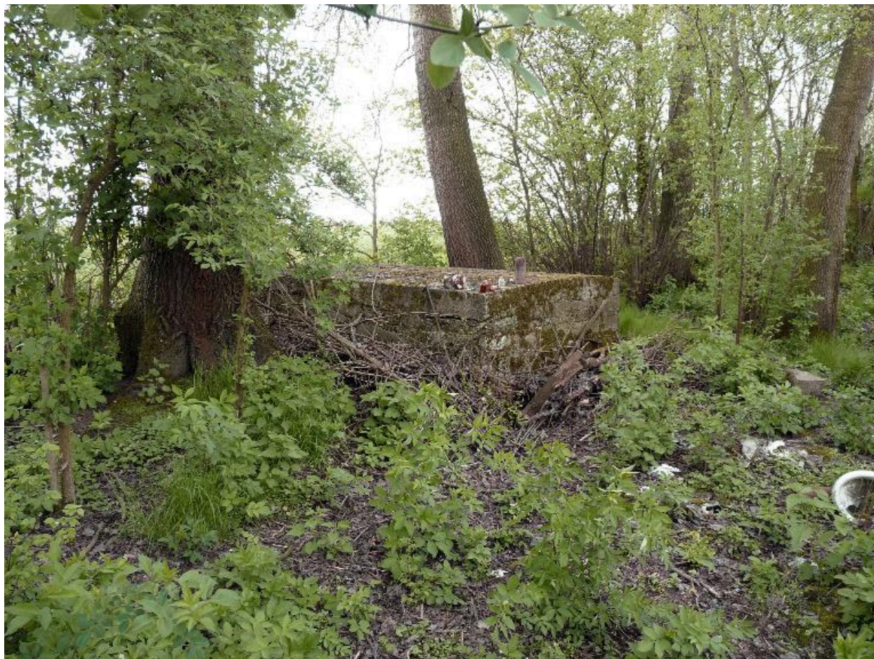
Casemate à munitions ? (611) vers le sud
