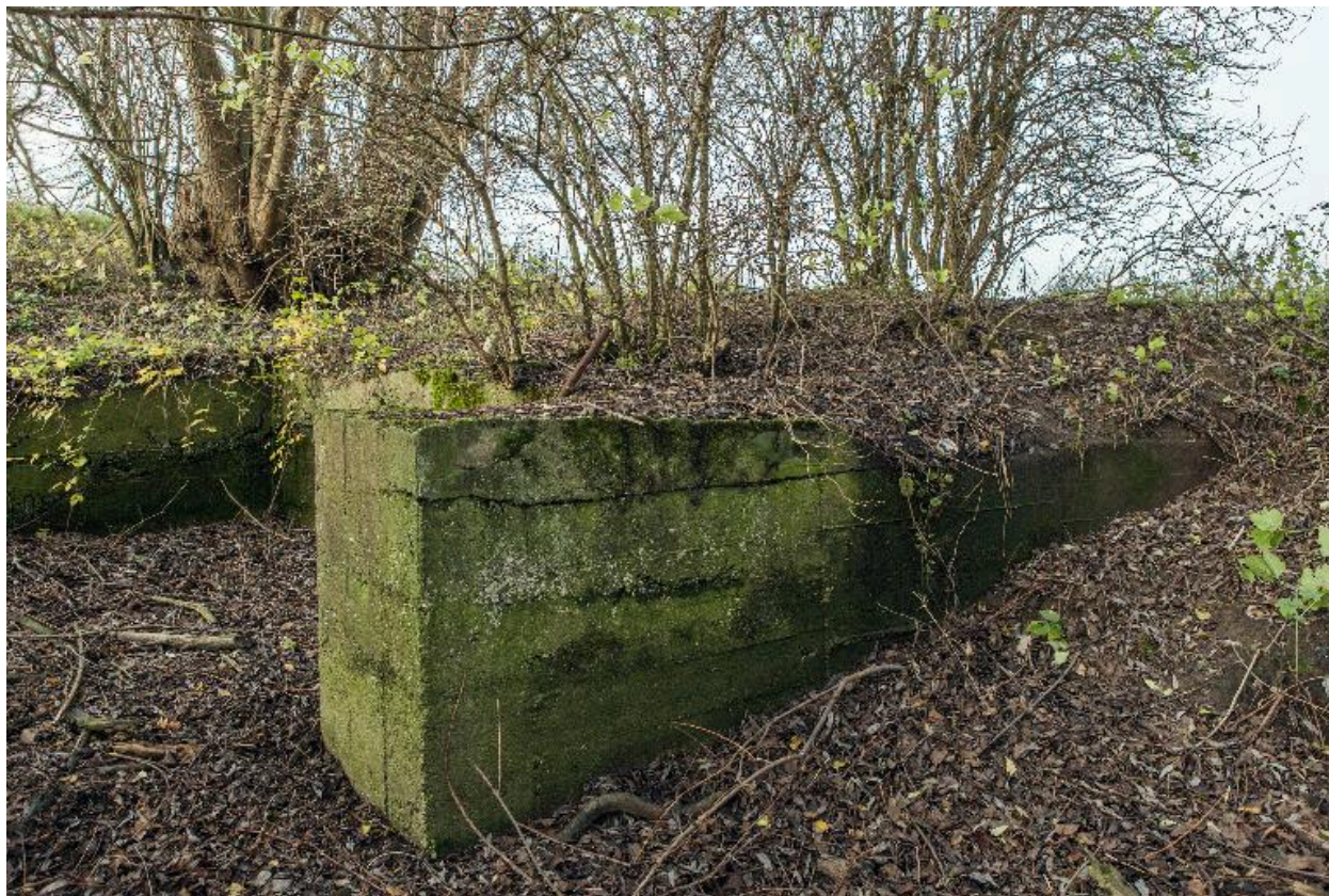
Cuve ouverte entre (88) et (89). Vers l'ouest
