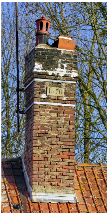
Date portée sur la souche de la cheminée de la maison, 1870, depuis l'ouest. Phot. Thierry Lefébure IVR32_20248000234NUCA
