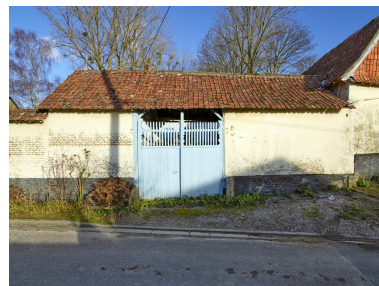
Vue de la grange sur rue et de sa porte charretière, depuis l'ouest. Phot. Thierry Lefébure IVR32_20248000232NUCA
