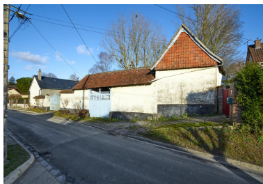
Vue des granges sur rue, depuis l'ouest. Phot. Thierry Lefébure IVR32_20248000230NUCA
