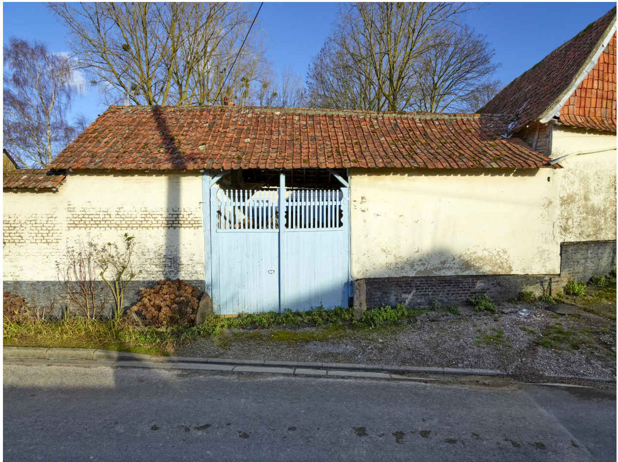
Vue de la grange sur rue et de sa porte charretière, depuis l'ouest.
