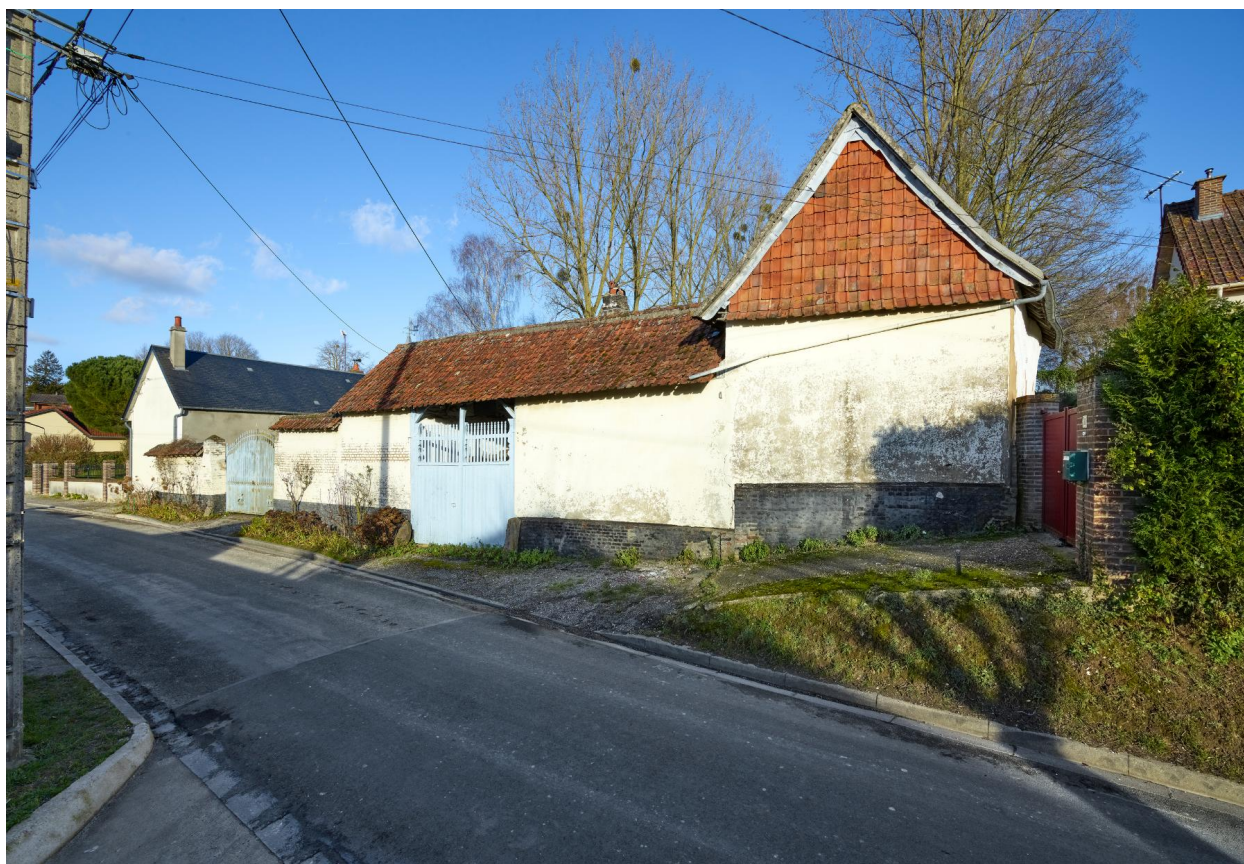
Vue des granges sur rue, depuis l'ouest.
