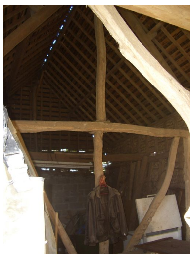
Vue d'une ferme de la charpente de la grange. Phot. Inès Guérin IVR22_20068005301NUCA
