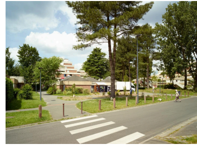
Le LCR Chanteclerc, du côté de l'allée Chanteclerc, est venu se nicher entre les trois pyramides au sein d'un espace vert récréatif qu'il contribue à animer. Phot. Pierre Thibaut IVR32_20185900658NUCA
