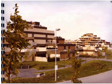
Vue prise depuis l'allée Chanteclerc, 1978. Les contrastes de couleurs (bandeaux marron) et les parements de brique soulignent les volumes des pyramides (AC Villeneuve d'Ascq, 16W3). Repro. Pierre Thibaut, Phot. auteur inconnu IVR32_20215900443NUCA
