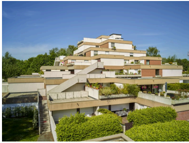
L'immeuble 267, allée Chardin. Des jardinières en béton viennent clôturer les terrasses, contribuant à végétaliser les pentes de chaque pyramide. Phot. Pierre Thibaut IVR32_20185900012NUCA
