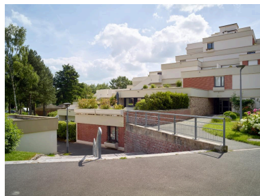
Vue prise depuis la partie haute de l'îlot, vers le sud et le LCR. Le chemin piétonnier dessert le 269, allée Chardin, puis emprunte un escalier. Phot. Pierre Thibaut IVR32_20185900638NUCA
