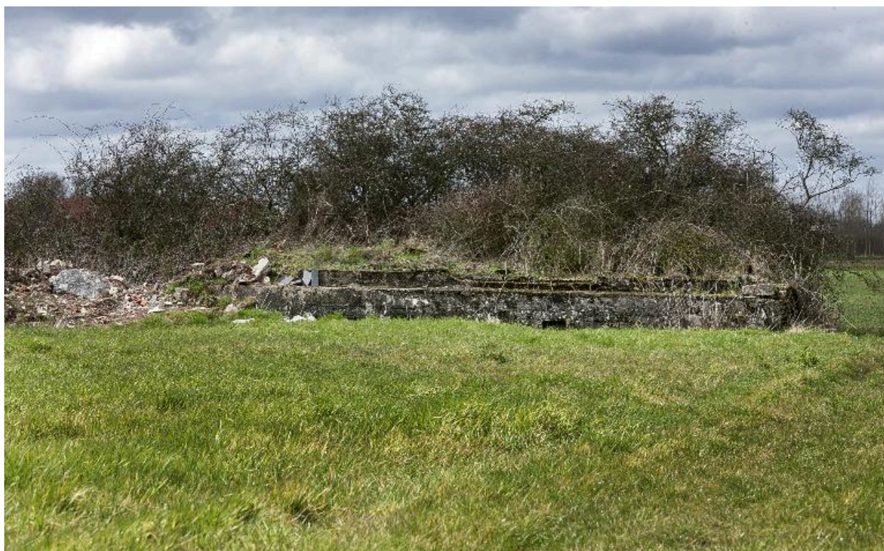
Elévation antérieure, vers l'ouest
