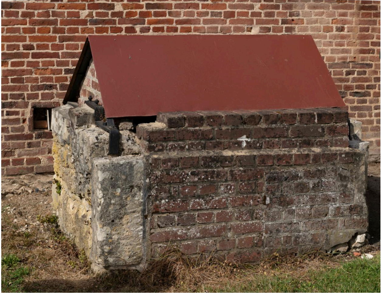
Ancien puits rue des Bonhommes (vers les n°11-13), vue depuis l'ouest.
