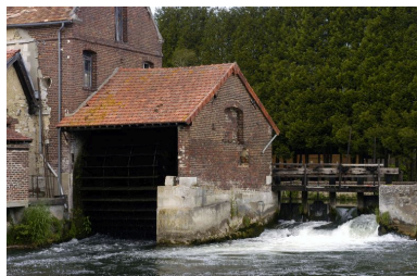
Vue d'ensemble de la roue hydraulique dans sa cage. Phot. Thierry Lefébure IVR22_20046000250XA
