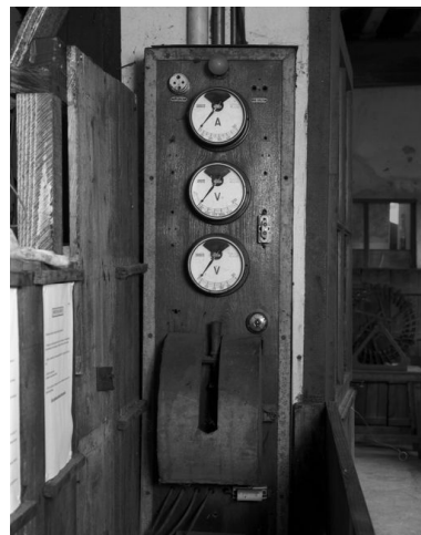
Le tableau électrique. Phot. Franck Bürjes IVR22_19996000018X
