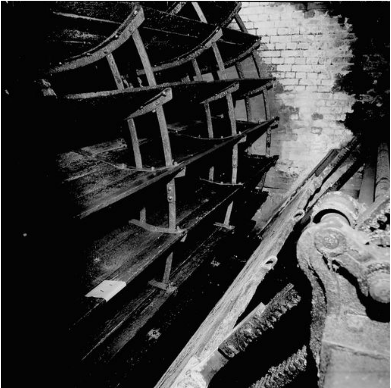
Vue de la vanne plongeante.
