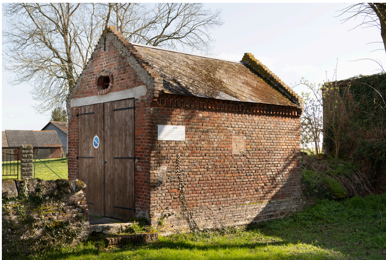
Ancienne remise des pompes à incendie, Grande Rue.
