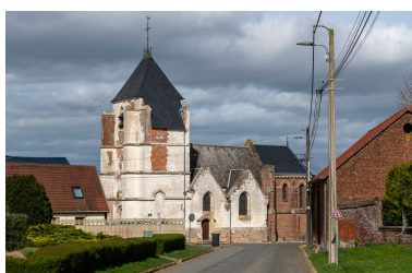
Vue générale de l'église depuis le sud. Phot. Marc Kérignard IVR32_20266000033NUCA
