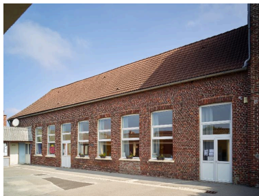
Vue générale des classes. Phot. Pierre Thibaut IVR31_20155901583NUCA
