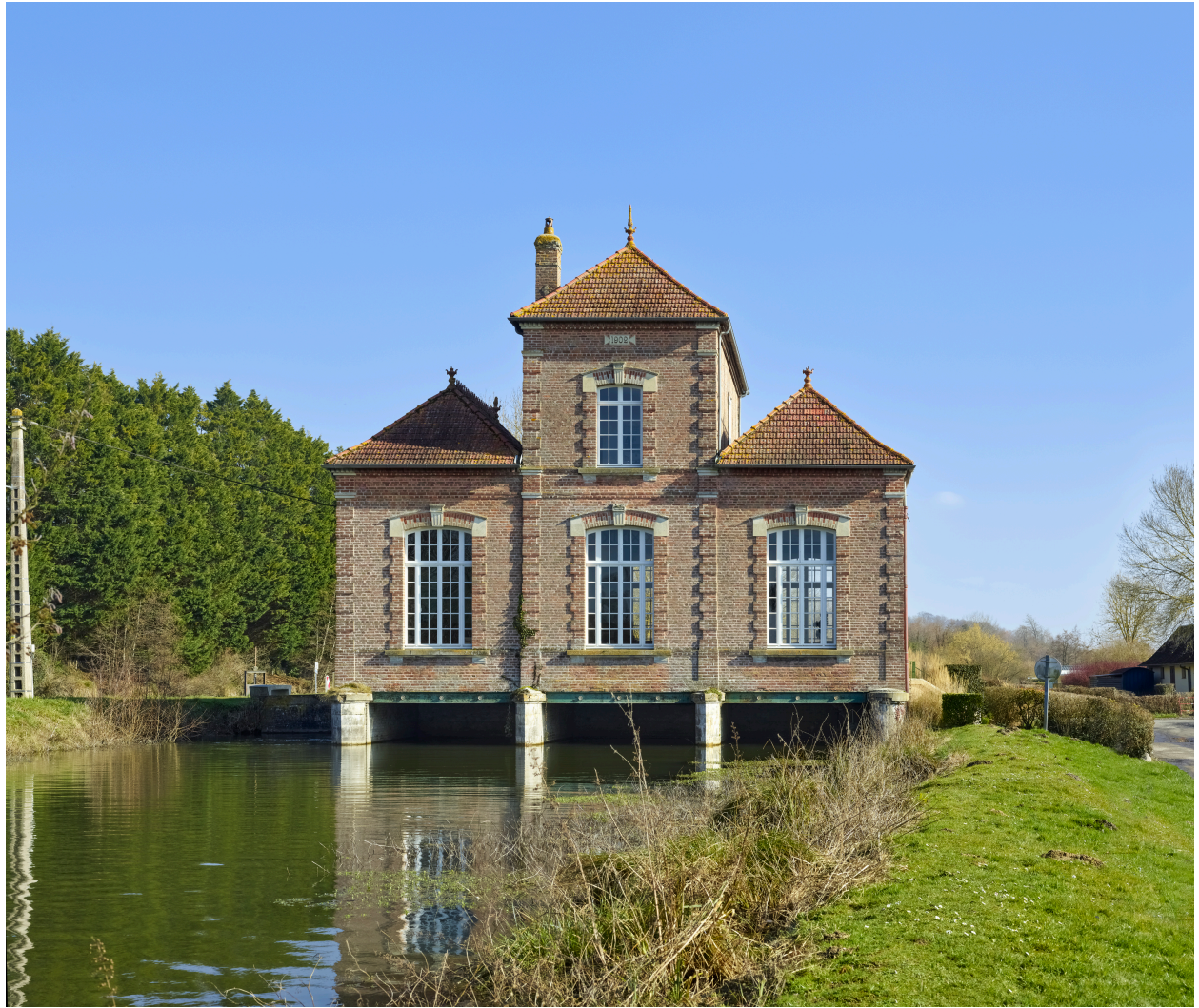
Vue de la façade est.
