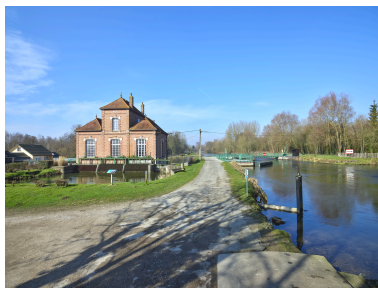
Vue de la centrale et du barrage du canal de déchargement, depuis l'ouest. Phot. Thierry Lefébure IVR32_20258000558NUCA
