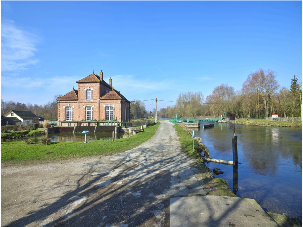
Vue de la centrale et du barrage du canal de déchargement, depuis l'ouest.
