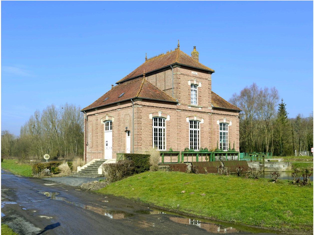
Vue de la centrale, depuis le sud-ouest.
