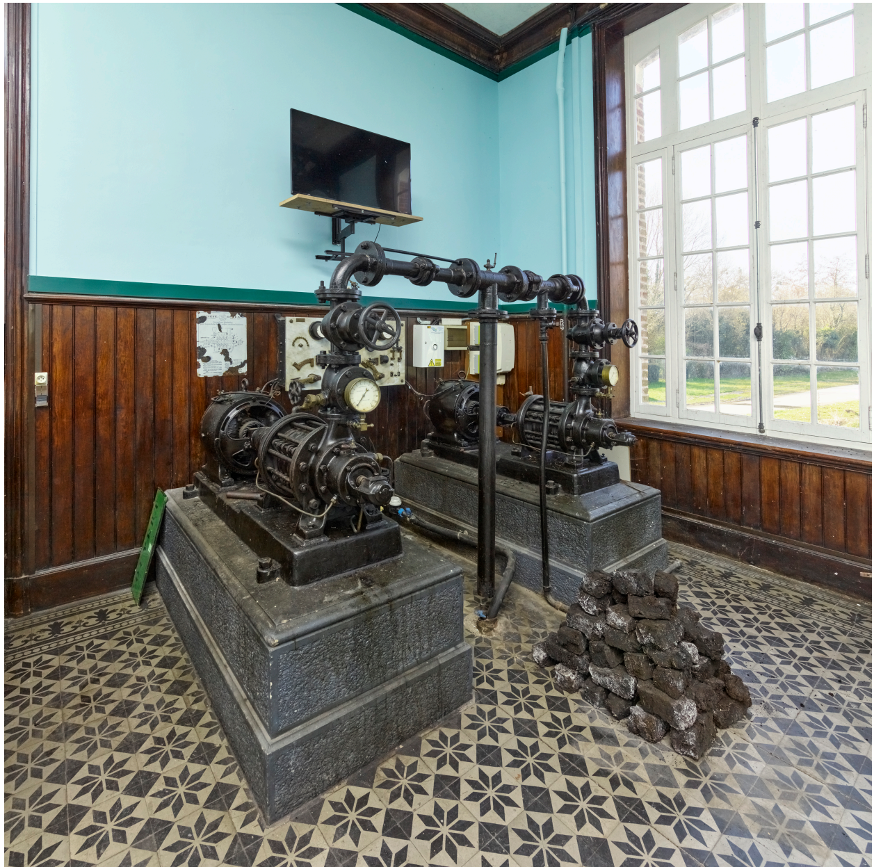
Intérieur, pompe à eau.
