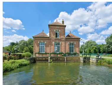
Vue de la façade ouest. Phot. Thierry Lefébure IVR32_20258000563NUCA
