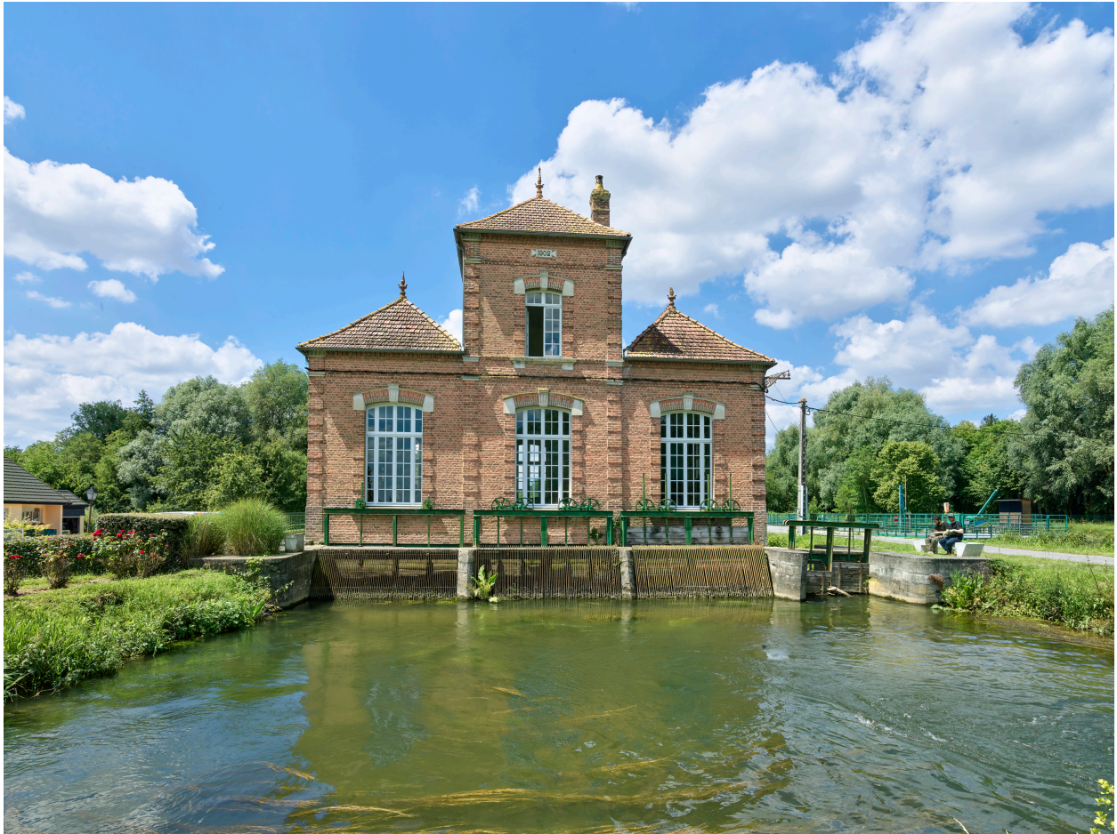
Vue de la façade ouest.
