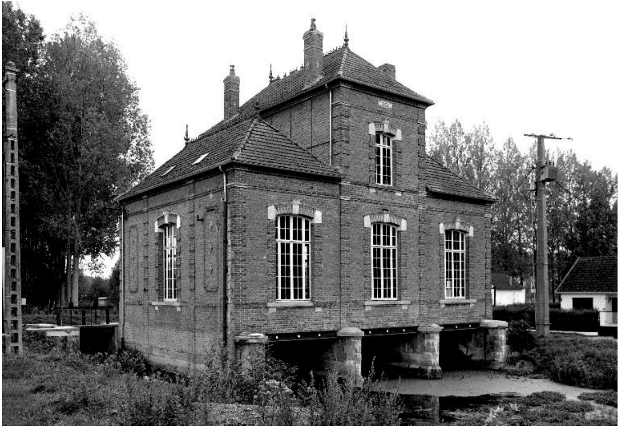
Vue d'ensemble, flanc ouest.
