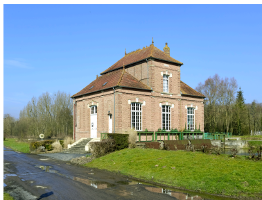
Vue de la centrale, depuis le sud-ouest. Phot. Thierry Lefébure IVR32_20258000560NUCA
