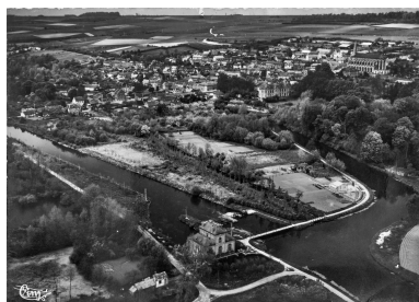
Vue aérienne de la centrale hydroélectrique, carte postale, Cim, ca 1949-1968 (coll. Jean-Paul Rouët). Repro. Thierry Lefébure IVR32_20258000668NUCA
