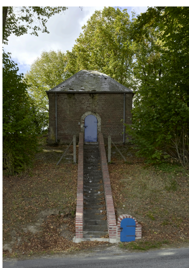
Le château d'eau. Phot. Thierry Lefébure IVR32_20258001468NUCA
