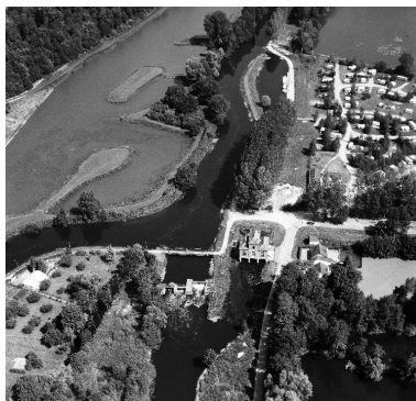
Vue aérienne, flanc ouest.
