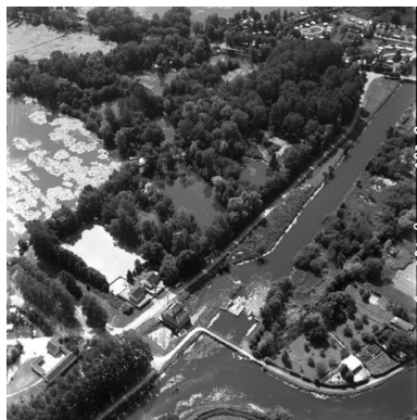
Vue aérienne, flanc nord-est.
