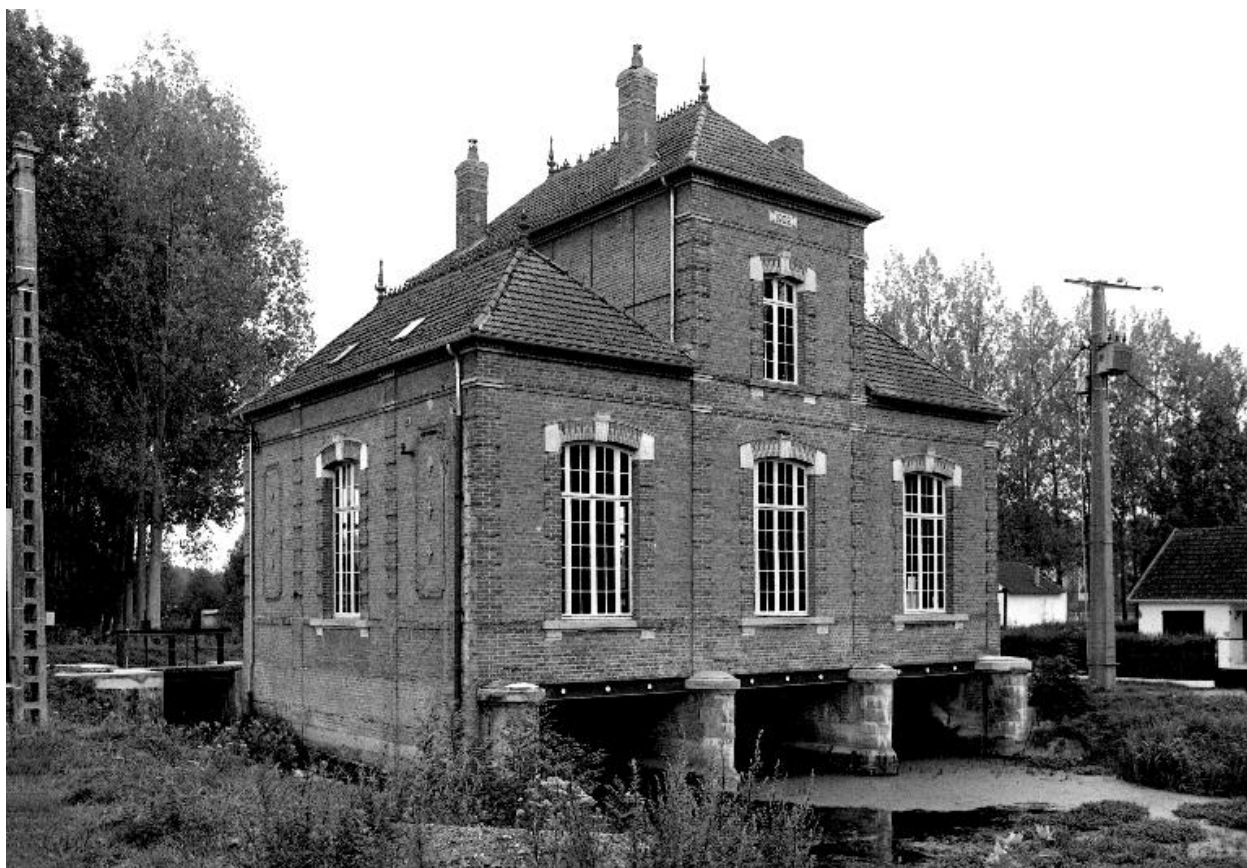
Vue d'ensemble, flanc ouest.
