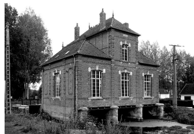
Vue d'ensemble, flanc ouest.
