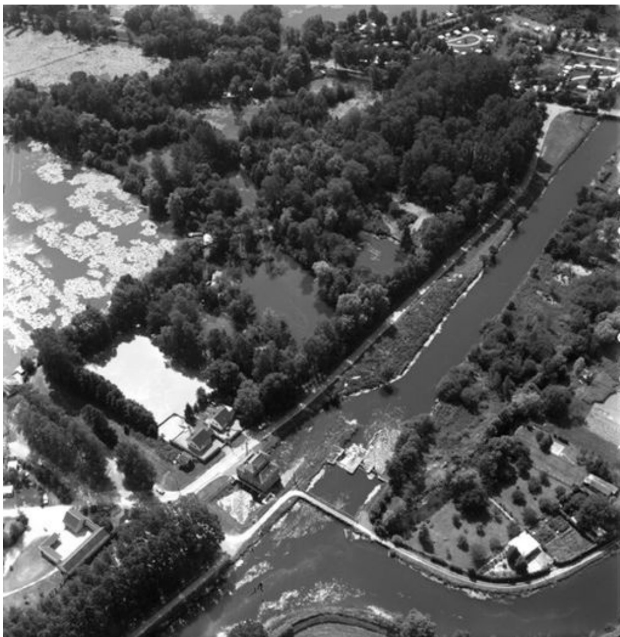
Vue aérienne, flanc nord-est.
