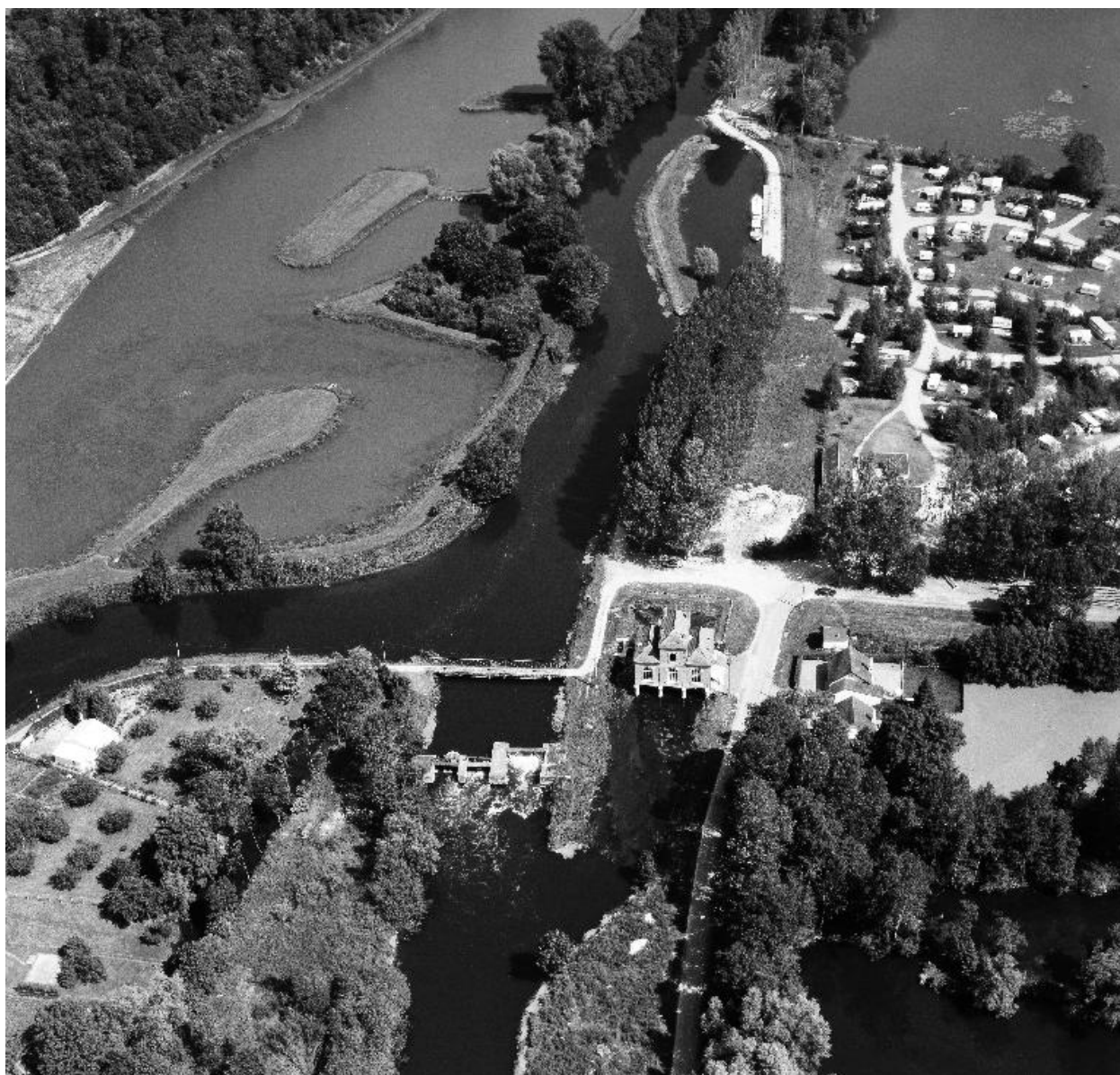
Vue aérienne, flanc ouest.
