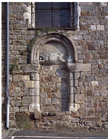
Vue de la porte romane, et du linteau, armorié du 14e ou du 15e siècle. Phot. Thierry Lefébure IVR22_19990202910VA
