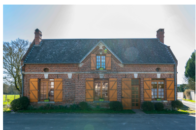
Ancien commerce, date portée de 1868, n°7 de la rue du Bois, vue depuis le nord.
