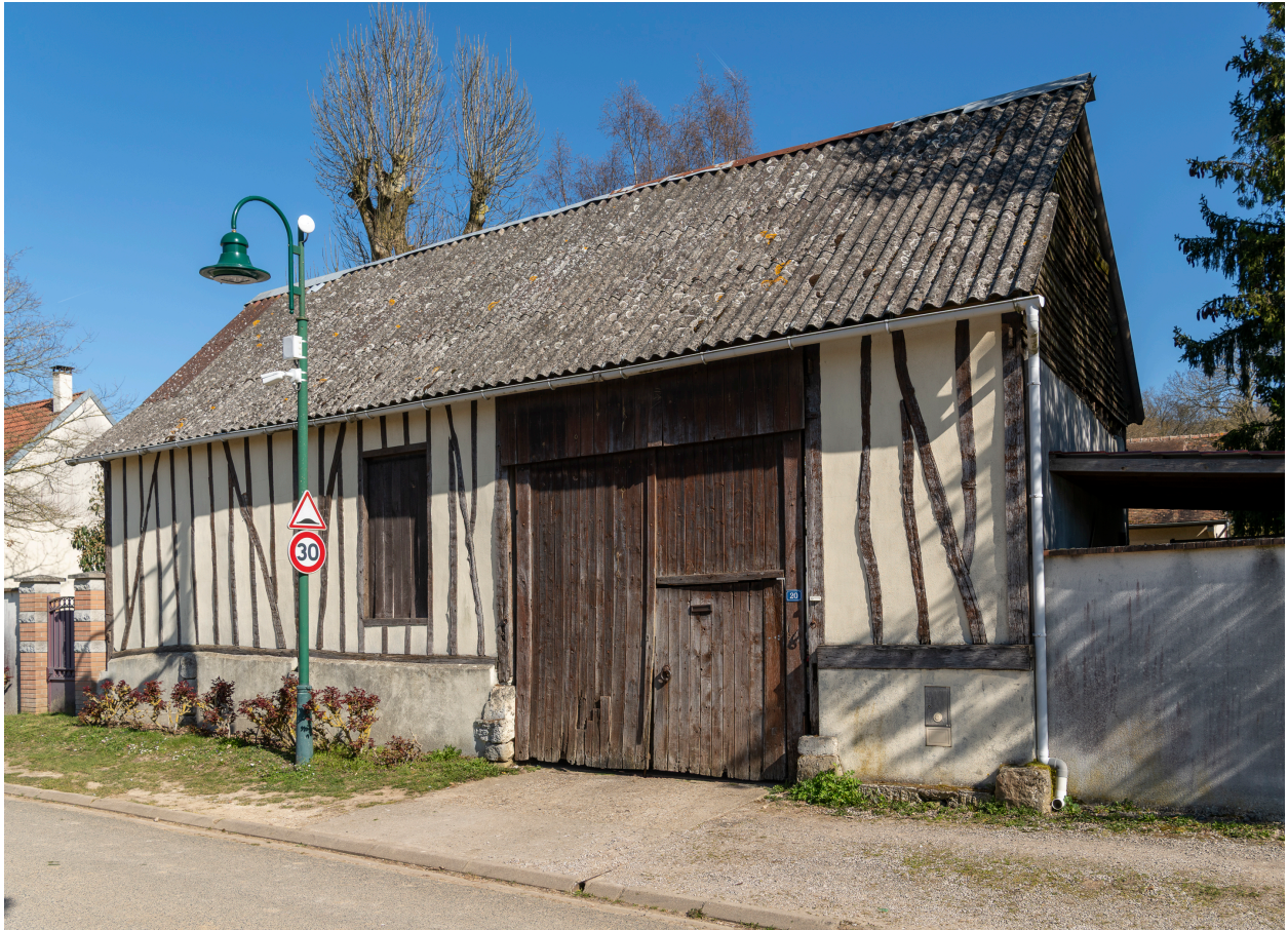
Ancienne grange sur rue avec entrée charretière et porte à engranger, n°20 de la rue Lefèvre, vue depuis le sud-ouest.
