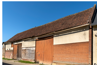
Ancienne grange sur rue avec deux entrées charretières, n°69 de la rue Behaize, vue depuis le sud.
