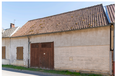
Ancienne grange sur rue percée d'une entrée charretière, n°54 de la rue Behaize, vue depuis le nord.
