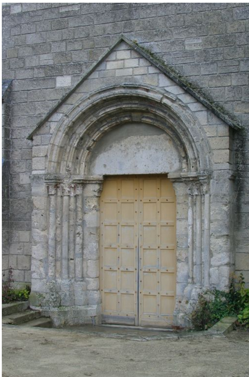
Vue d'ensemble du portail ouest.
