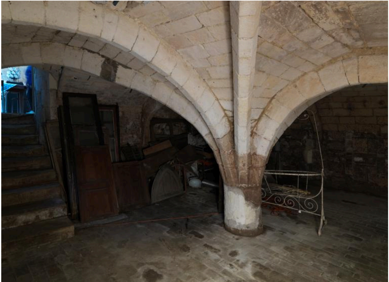
Ancienne hôtellerie de l'Enfer, cave médiévale voûtée en palmier, sous le logis.
