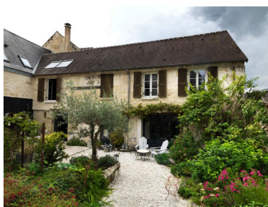
Ancienne hôtellerie de l'Enfer, cour et façade des communs réaménagés en logement.
