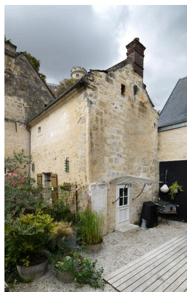
Ancienne hôtellerie de l'Enfer, vue de l'ancienne cuisine sur la cour. Phot. Thierry Lefébure IVR32_20206000148NUC2AQ
