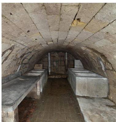
Ancienne hôtellerie de l'Enfer : cave aménagée en cellier réfrigéré sous l'ancienne cuisine.
