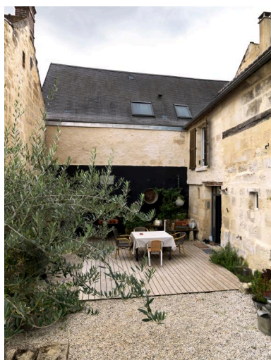
Ancienne hôtellerie de l'Enfer, la cour intérieure entre l'ancienne cuisine, l'ancienne annexe du restaurant et les communs réaménagés en logement.
