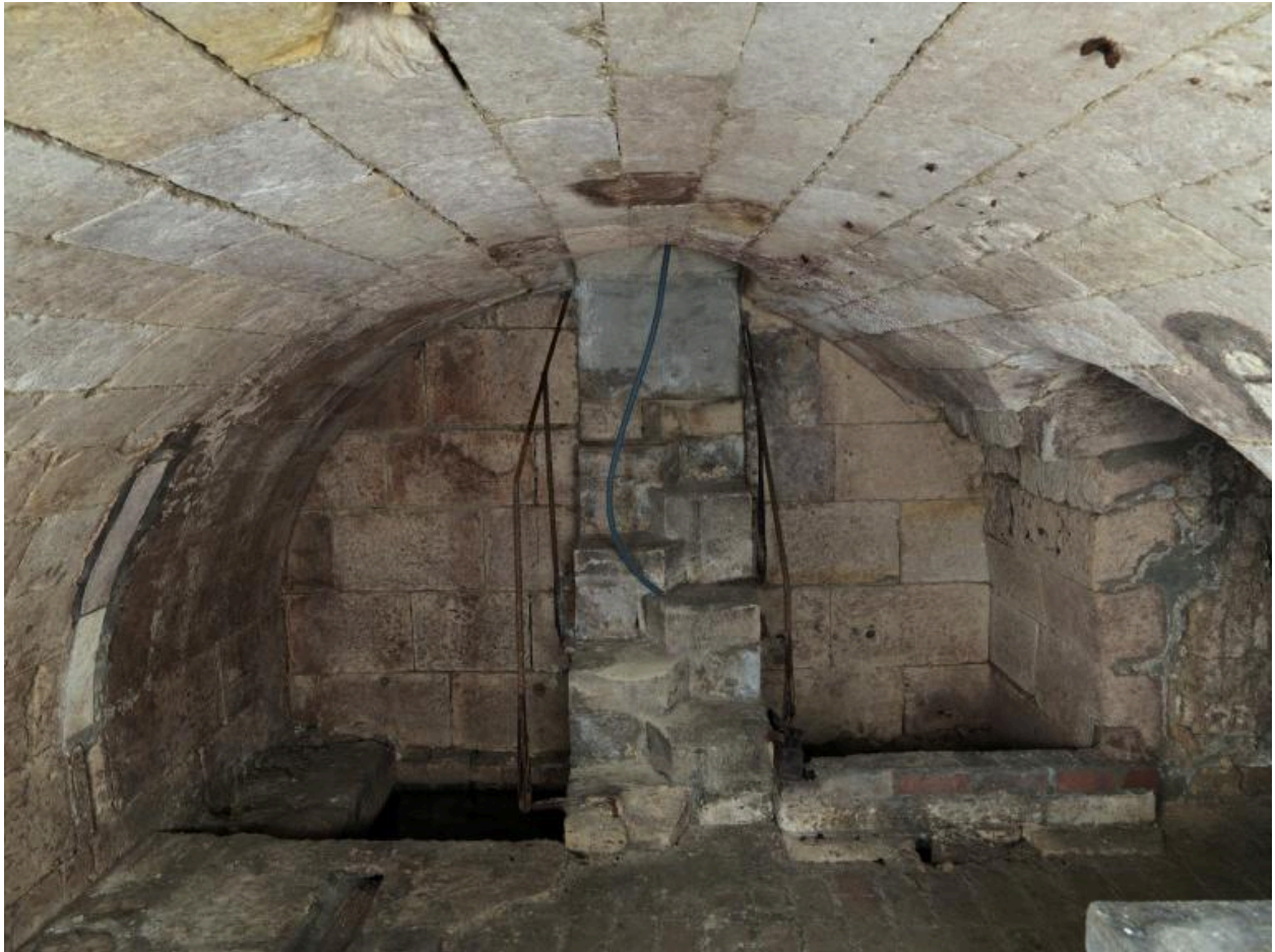
Ancienne hôtellerie de l'Enfer : cave aménagée en cellier réfrigéré sous l'ancienne cuisine.
