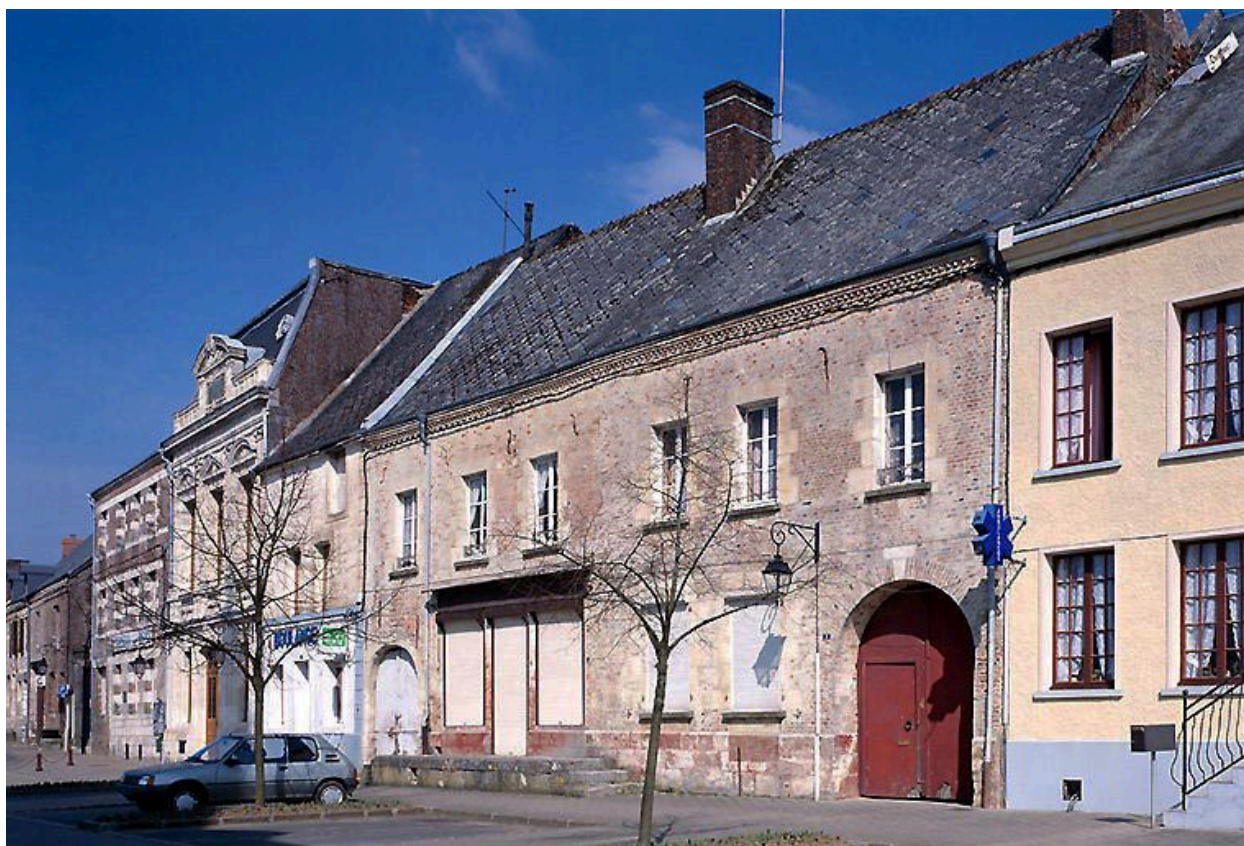
Vue depuis le sud-est.
